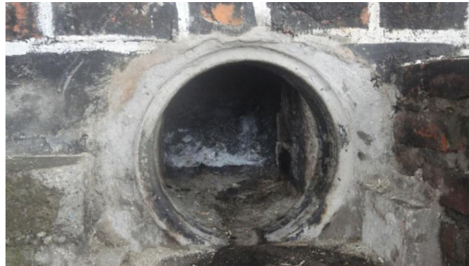
Gráfico 26: Cámara de combustión
