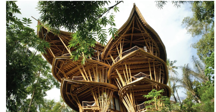
Figura No. 4.4.1. Ejemplo de arquitectura con caña guadua. Bamboo Bali House.
