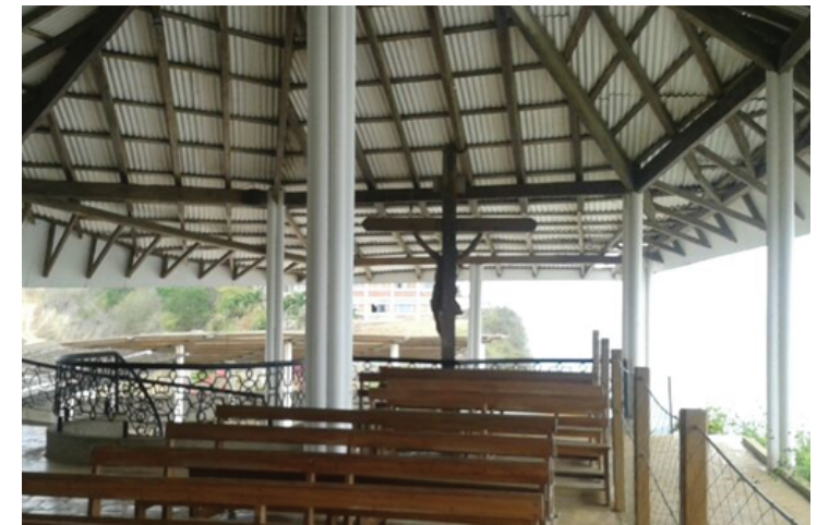
Figura No. 4.4.1.13. Vista interior con detalle de cubierta. Fuente. Ecuavisa.
