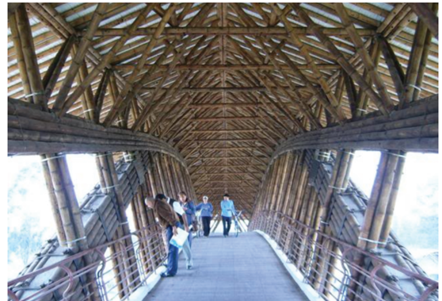
Figura No. 1.6.1. Puente de caña guadua en Bogotá. Fuente. SkyscraperCity.
