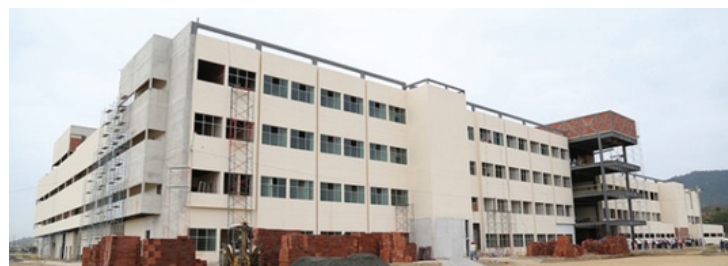
Figura No. 3.7.1. Avance de obra de Agosto del 2015. Fuente. El Ciudadano.
