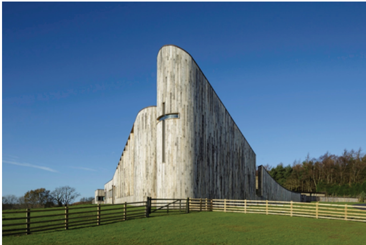
Figura No. 4.4.1.5. Fachada posterior de Iglesia Stanbrook Abbey. Fuente. ArchDaily (Tim Crocker).
