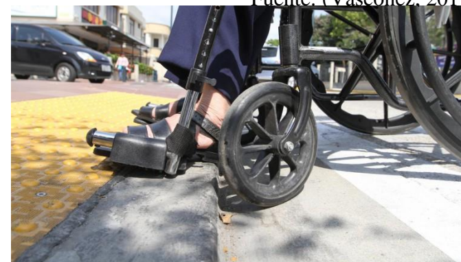
Imagen 4 Falta de continuidad en rampas.
