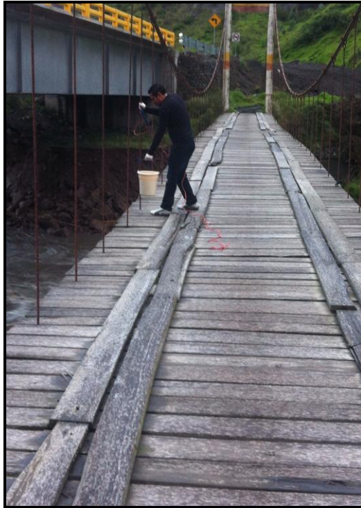
Fotografía 6: Puente nuevo Cahuaji Bajo
