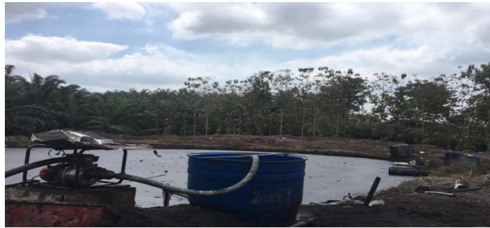
Figura 14. Piscina de aguas residuales – Extractora “Oleorios”
