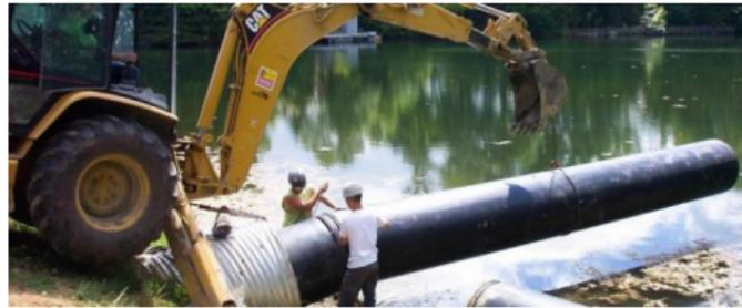
Figura 3.8. Recubrimiento interior por empuje
