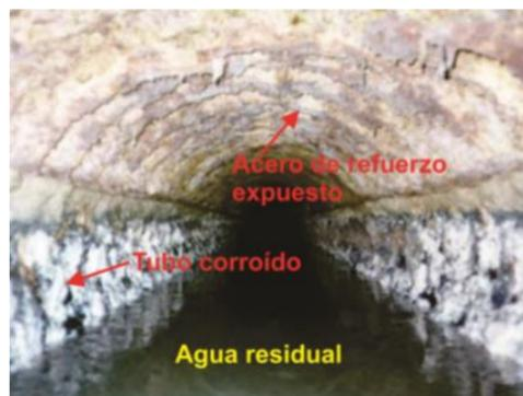
**FIGURA 5: Corrosión en tubería de concreto por acero**
