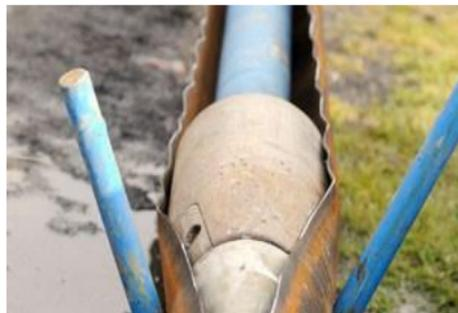
**FIGURA 6: Fragmentación de tubería de acero**
