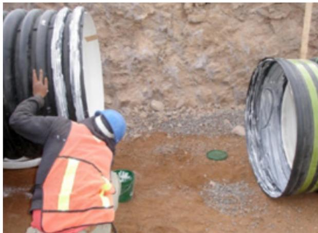
**FIGURA 43:** limpieza y lubricación de piezas.
