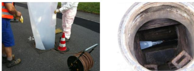
FIGURA 24: **Introducción de lámina deslizante**
