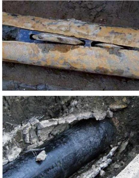
**FIGURA 9: Sustitución de tubería sin zanja**
