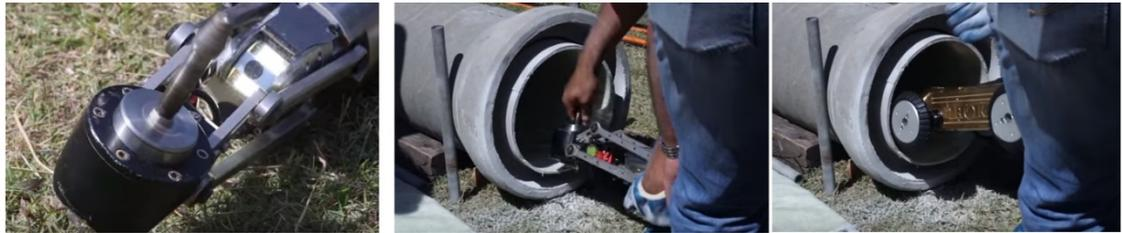
**FIGURA 40:** Reparación con resinas.
