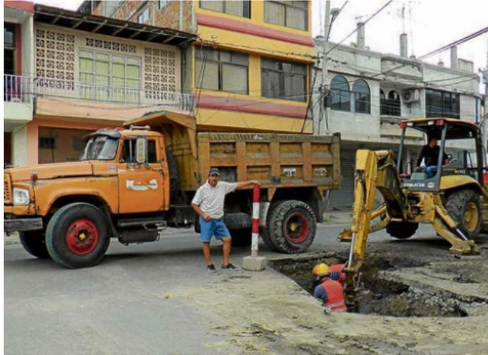
**FIGURA 34:** Excavación de la zanja.
