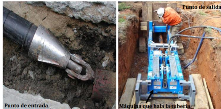
**FIGURA 7: Puntos de inicio y fin de la tubería sustituida sin zanja**
