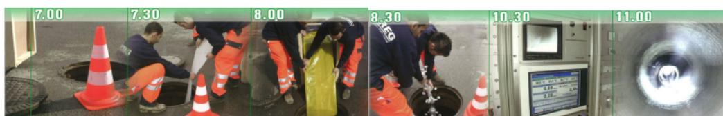
FIGURA 23: Procedimiento de curado
