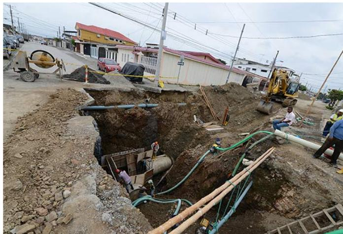
**FIGURA 35:** reparación de la tubería.
