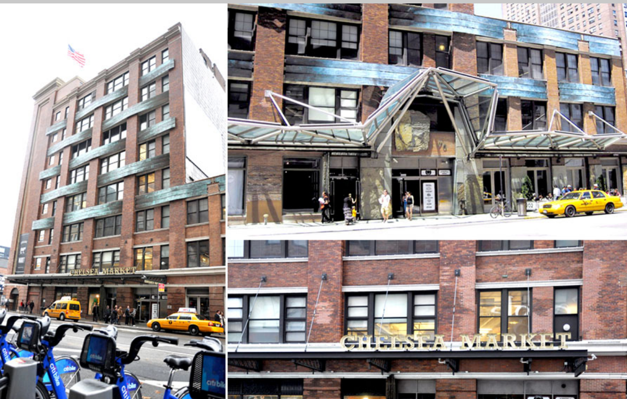
Figura N.52: Tomas de Fachada Principal Fuente: (NYC Architecture, 2013)
