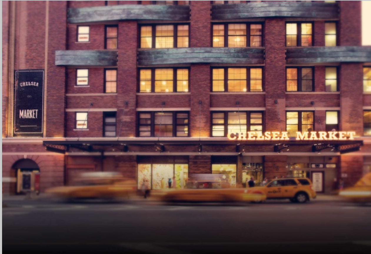
Figura N.50: Fotografía del ingreso principal al mercado. Fuente: (Dorio, Miller, Harlan, Manhattan, & Singluff)
