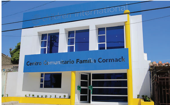
Ilustración 13: Edificación del Centro Comunitario Familia Cormack. Fuente Children International Org.
