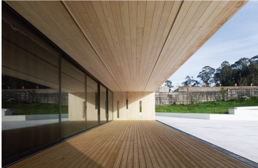
Ilustración 28: Pórtico con elementos vistos (madera y enlucido pulido). Fuente: Plataforma Arquitectura.
