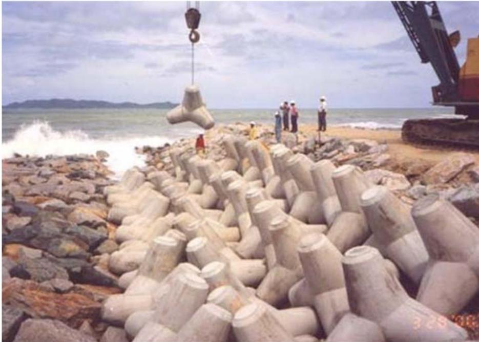
**Figura 18: Colocación de tetrapodos con grúa.**
