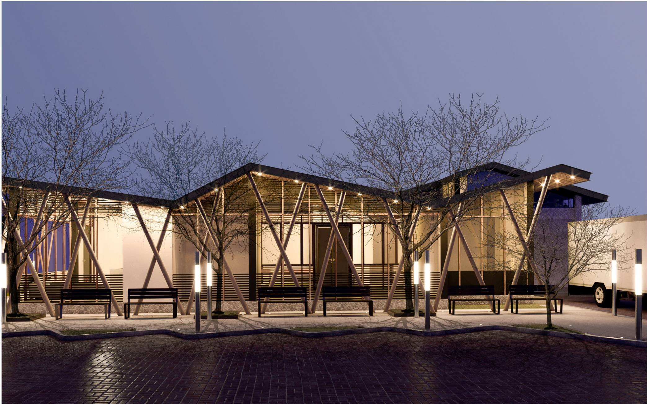
Figura 24. Vista lateral derecho del edificio
