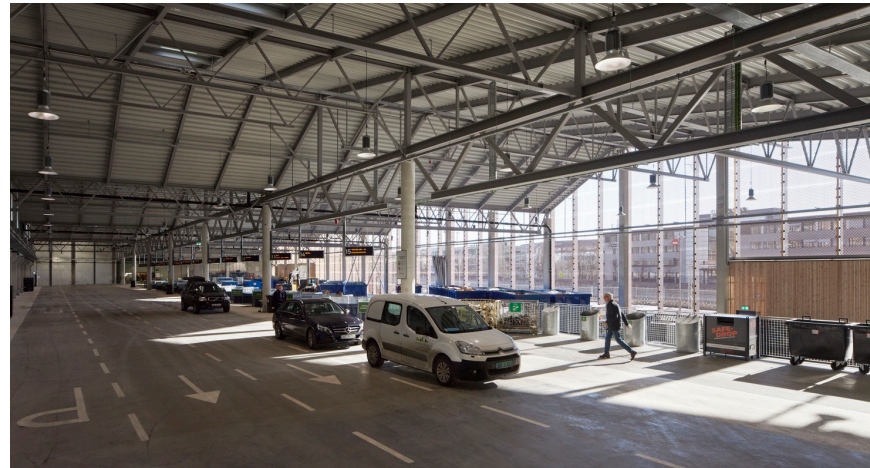
Figura 14. Interior del centro de acopio de reciclaje Smestad
