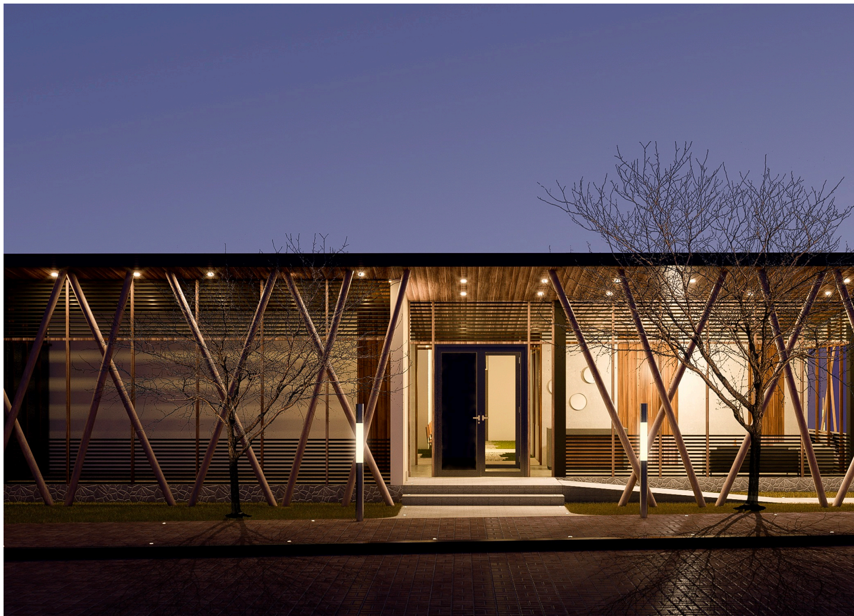
Figura 26. Vista frontal del edificio
