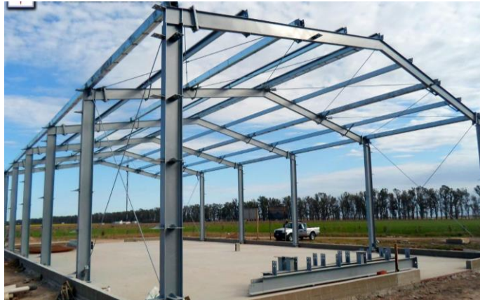
Diseño y construcción de Area de Acopio
