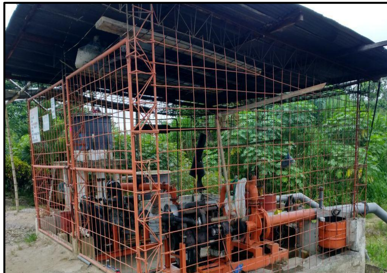
Implementación de Sistema de Riego
