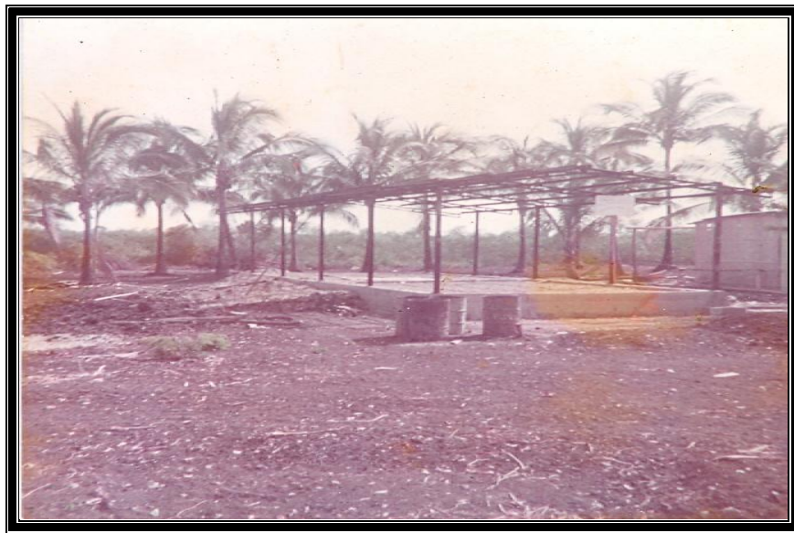
Figura 7: Construcción del primer pabellón de la Escuela Mixta No. 7 Mariana Rodas de Prieto
