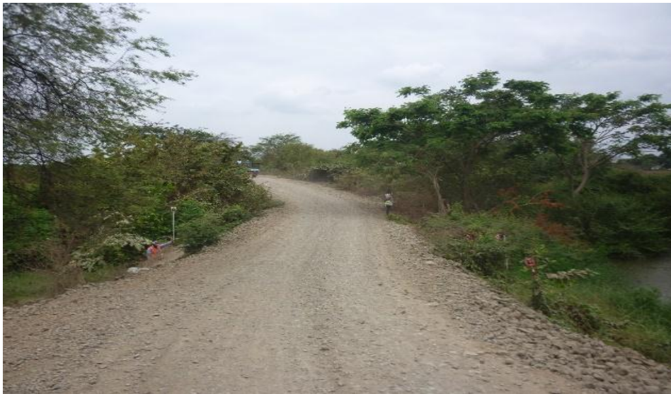
Figura 6.- Vía San Gabriel – Estación de Bombeo – Las Cañas, Cantones: Daule y Lomas de Sargentillo.
