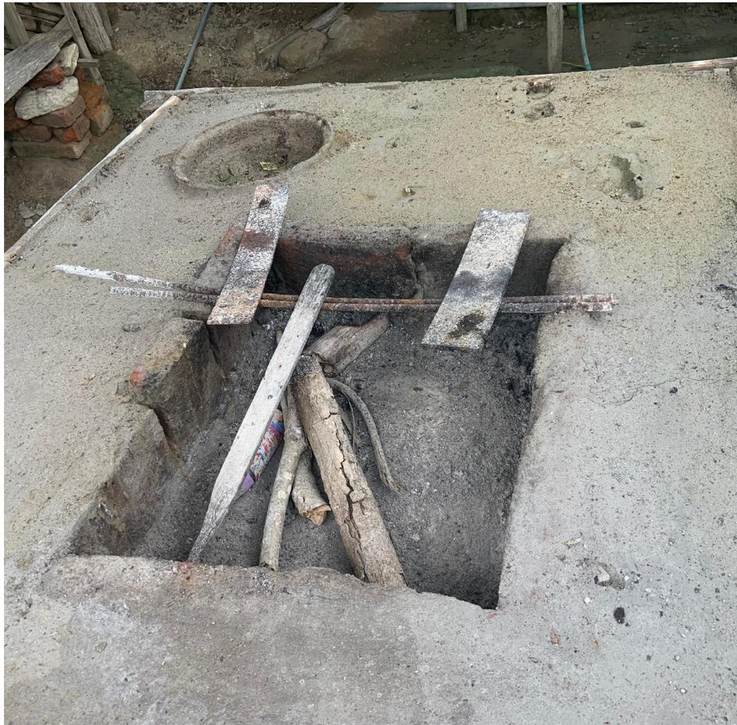
Según datos de Gonzalo Intriago para las columnas usan caña que es enterrada en la arena para darle más rigidez a la casa, o si no hubiera madera de Guayacán (árbol que se encuentra en Puerto Cabuyal), para las vigas madera de Laurel, para las paredes usan caña picada. Para realizar los amarres usan tiras de plástico que anclan el techo con la estructura.
