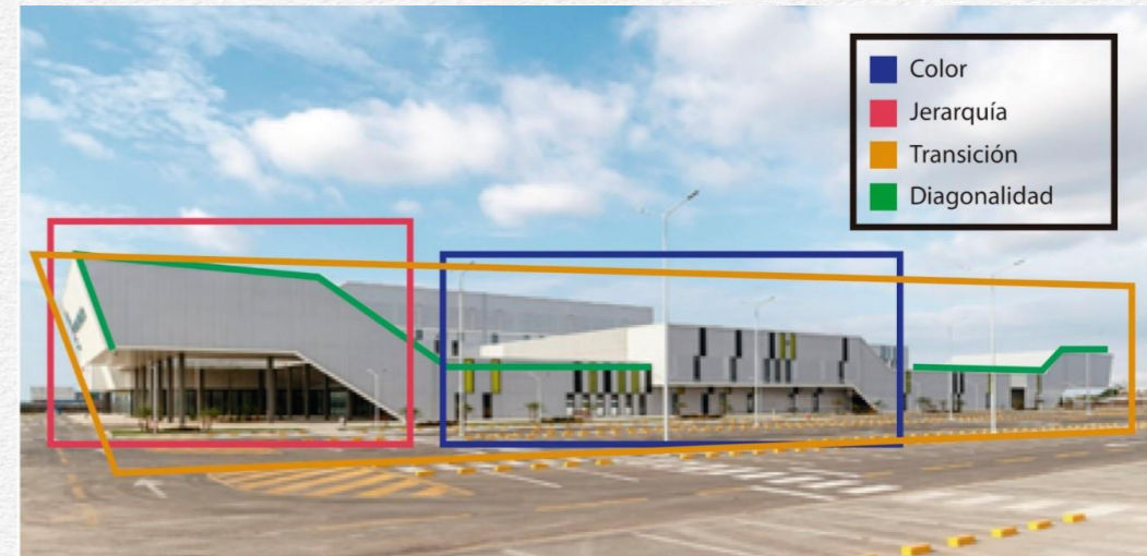
Imagen 43: Vista general al moderno hospital ubicado en la ciudad de Manta.
