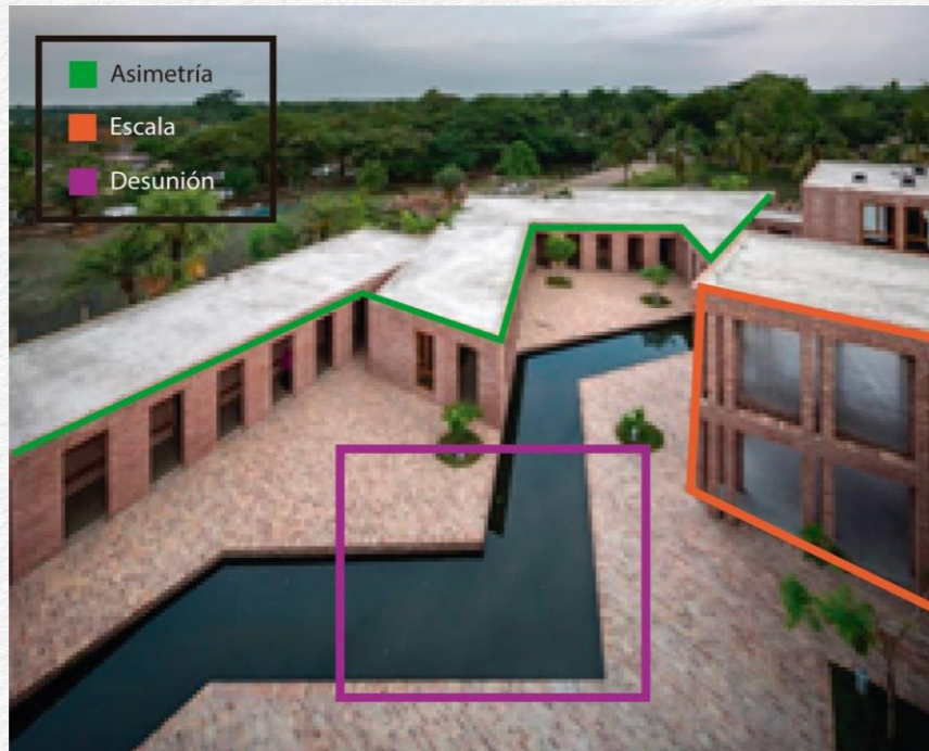
Imagen 71: Vista del Hospital Friendship donde se aprecia el espejo de agua.
