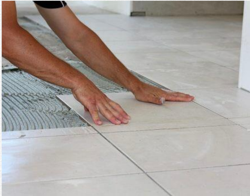
Imagen 198: Instalación de pisos.
