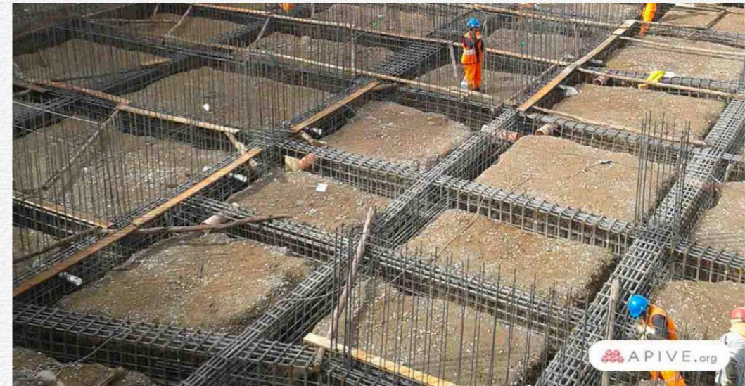
Imagen 193: Cimentación de edificio.
