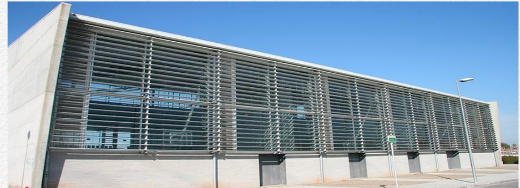
Imagen 199: Instalación de quiebrasoles.
