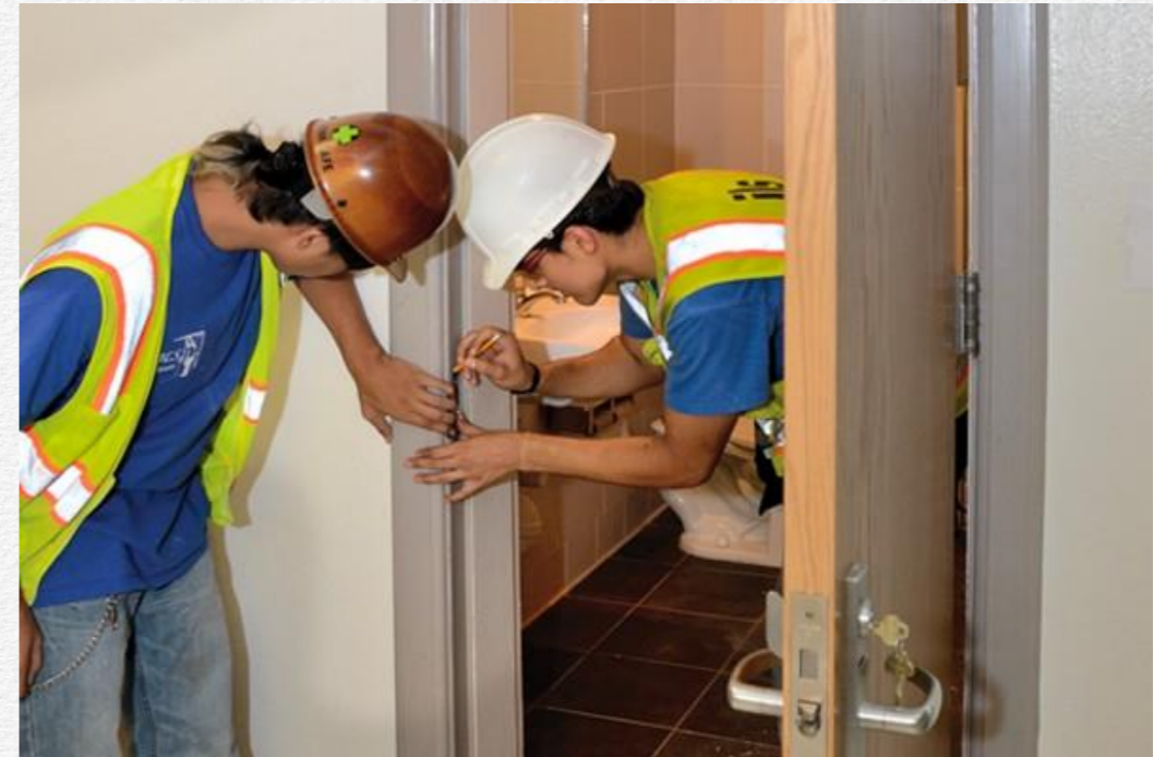
Imagen 197: Instalación de puertas.
