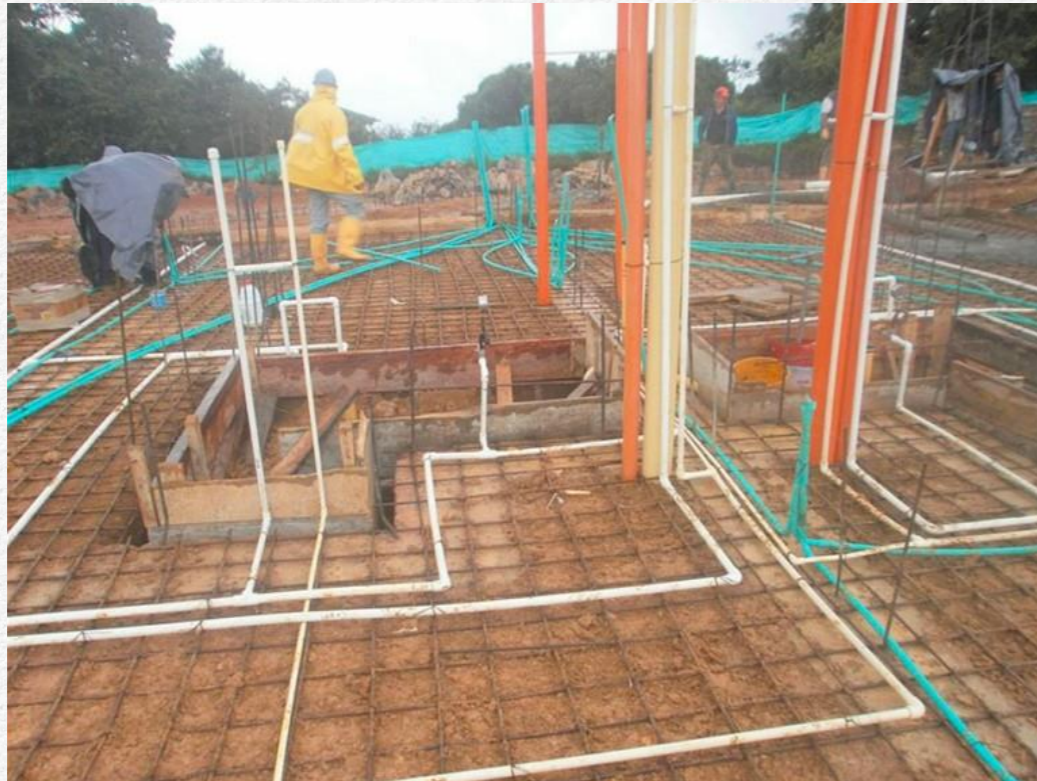
Imagen 196: Instalaciones previo a fundición de contrapiso.
