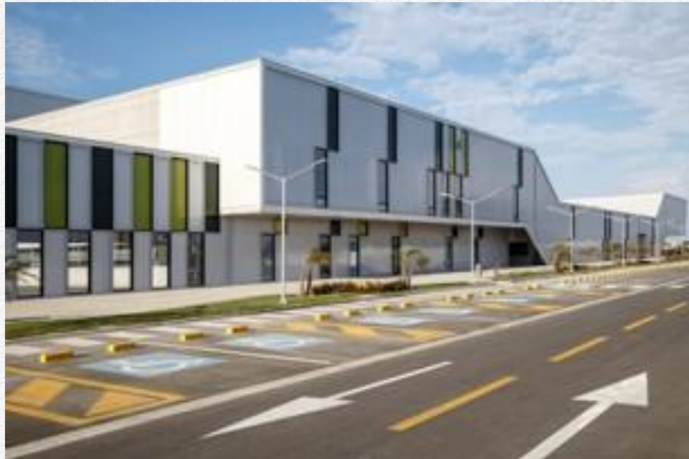
Imagen 41: Se aprecian los juegos de vitrales, los cuales benefician por la entrada de luz natural.
