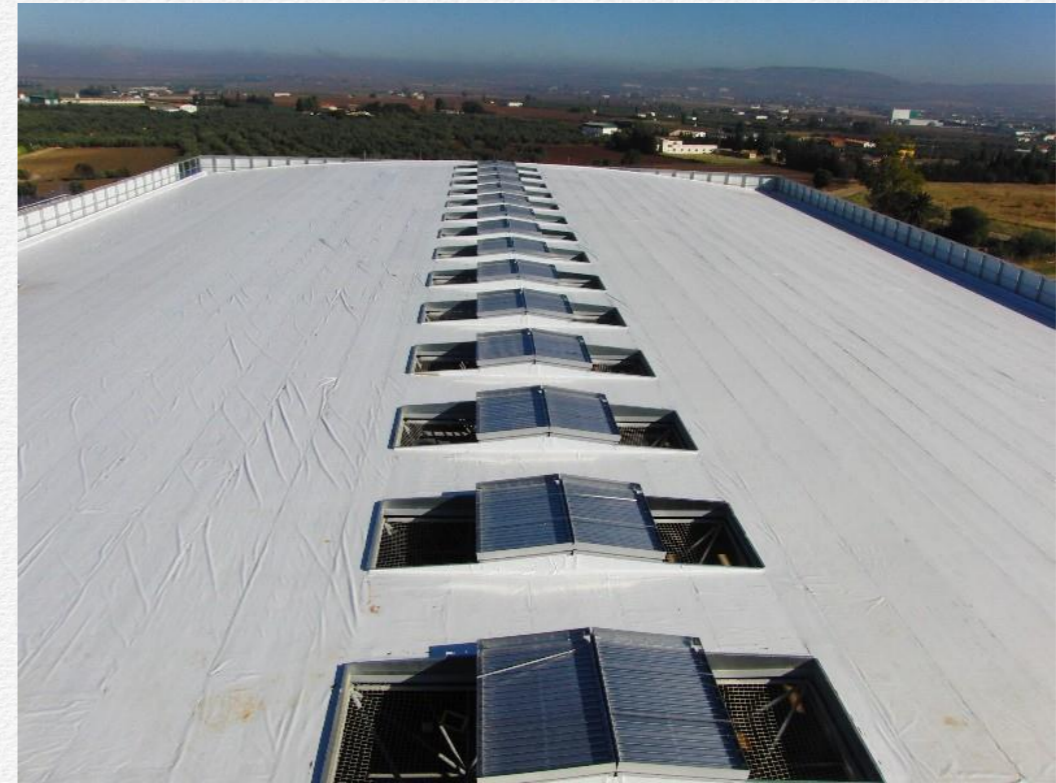
Imagen 195: Cubierta de edificación.
