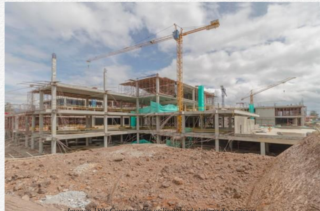
Imagen 189: Construcción utilizando el sistema de pórticos.
