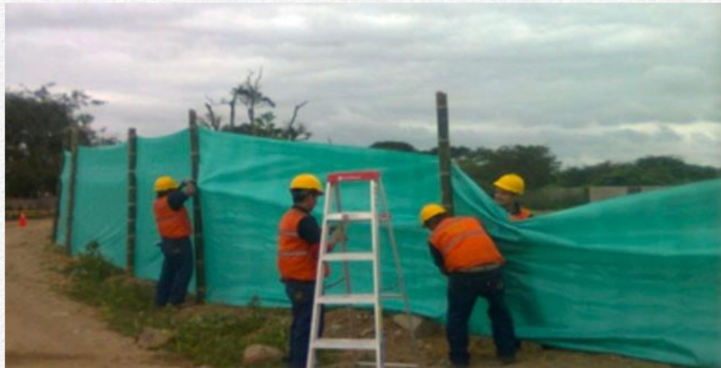
Imagen 192: Cerramiento provisional de obra.
