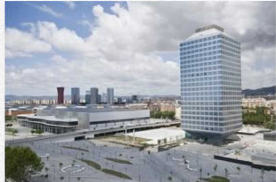
Imagen 23: Vista panorámica del edificio Iberdrola, ubicado en la ciudad de Barcelona, España
