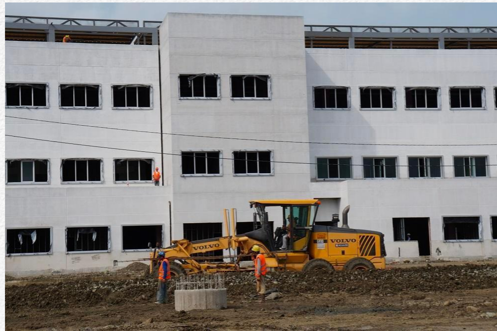
Imagen 10: Construcción del Hospital de Manabí
