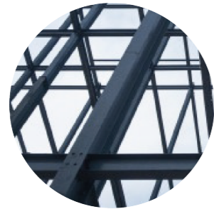
ESTRUCTURA DE ACERO
