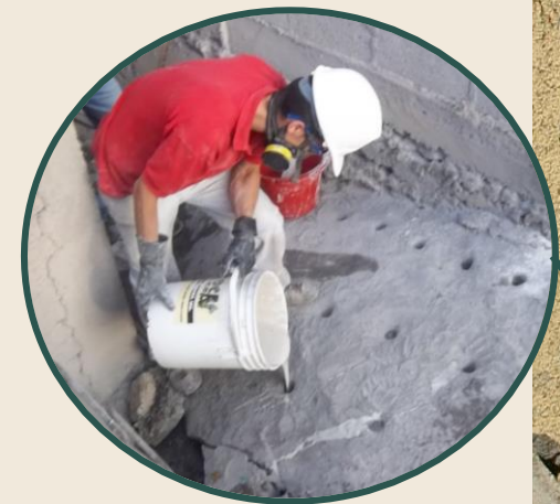
Técnica de cemento expansivo. Fuente: (Rocanebras, 2011)
