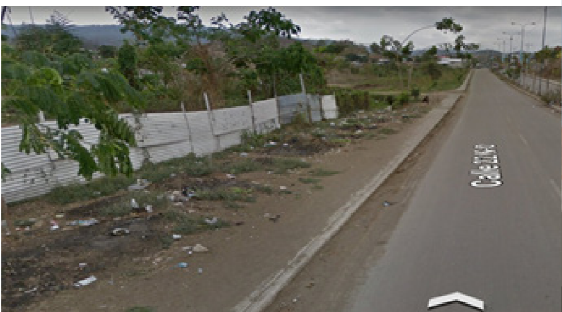
Ilustración 60: aceras parcialmente cubiertas de tierra. Fuente: (Google Earth, 2021)
