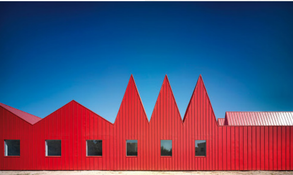
Ilustración 37: Fachada centro de rehabilitación. Fuente: (Granada, 2011).
