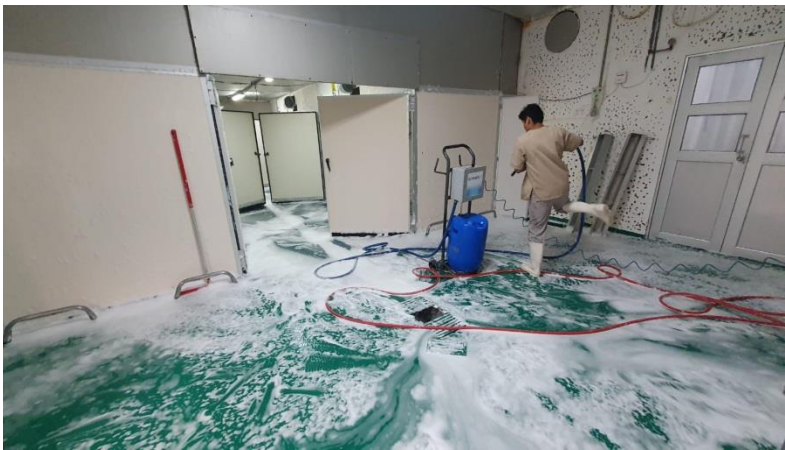
Figura 20. Personal realizando trabajos de limpieza
