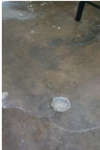
Figura 7. Cascarillas dispuestas por la rejilla de agua residual
