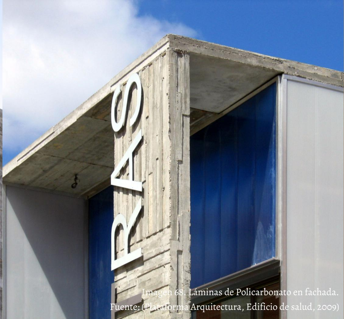
Imagen 68. Láminas de Policarbonato en fachada.
