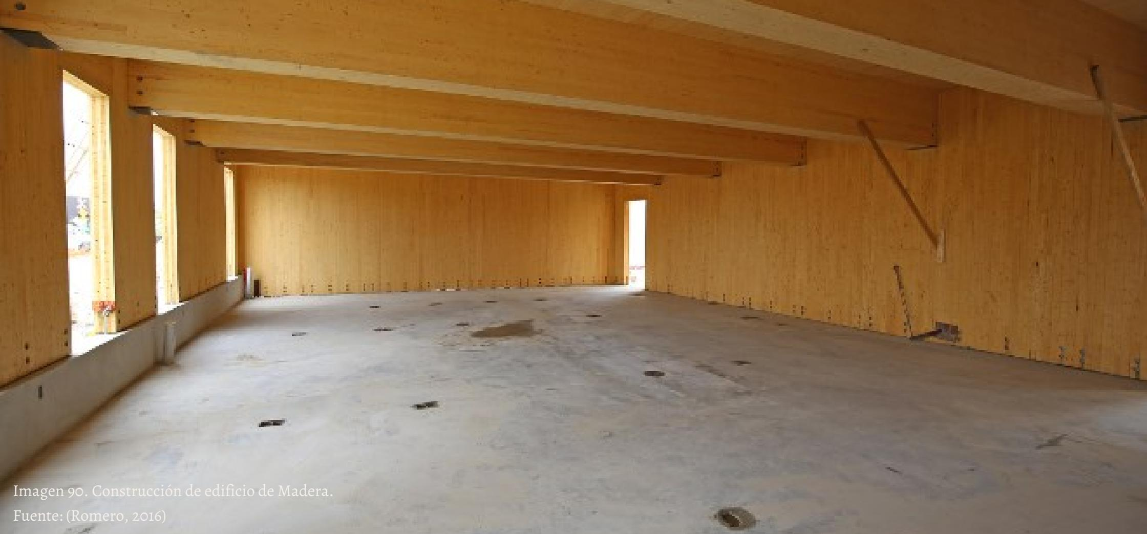
Imagen 90. Construcción de edificio de Madera.
