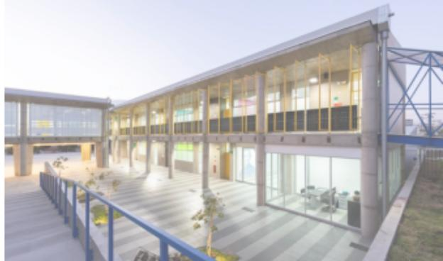
El esqueleto de la institución esta compuesto por pilares y vigas de hormigón al descubierto. No existe revestimiento ni enlucido y pintado. Se consigue una fachada de planos seriados a través de elementos metálicos de color amarillo que tienen únicamente función estética. Por otro lado quebra soles estan ubicados en la cara donde se recibe mayor impacto del sol durante el día.
