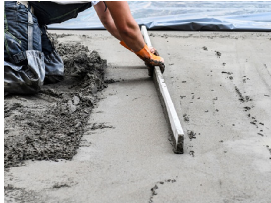
Imagen 10: Hormigón (Fuente: Poyatos)
