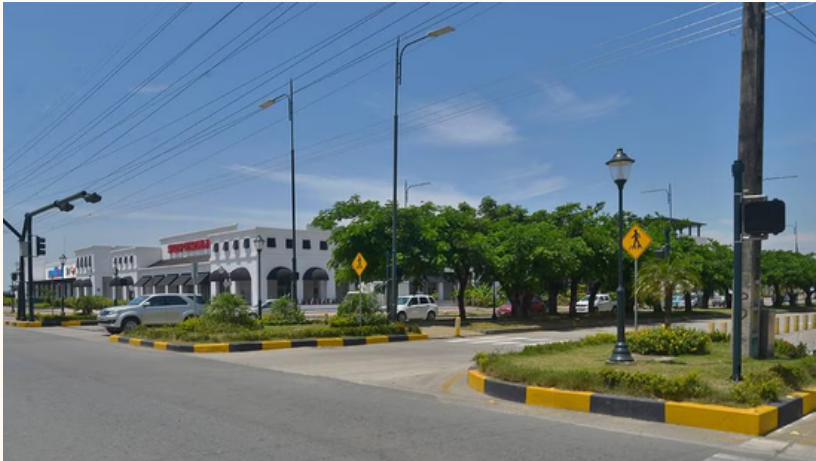
Imagen 51 Avenida Samborondón Fuente: Google Maps (2023).
