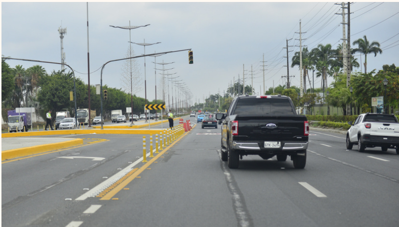
Imagen 52 Avenida Samborondón Fuente: Google Maps (2023).
