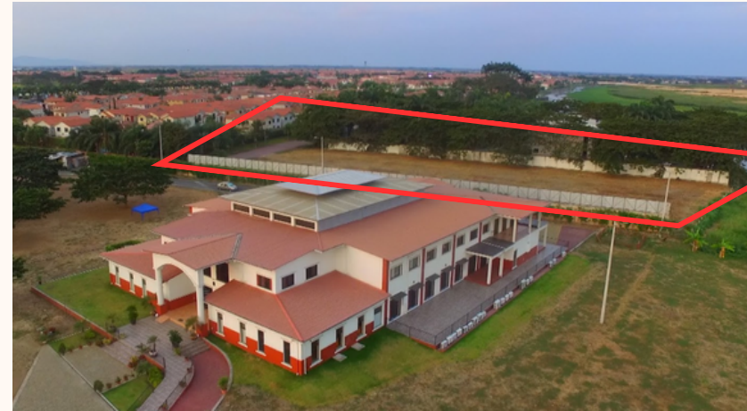
Imagen 57 Terreno Fuente: Google Maps (2023).
