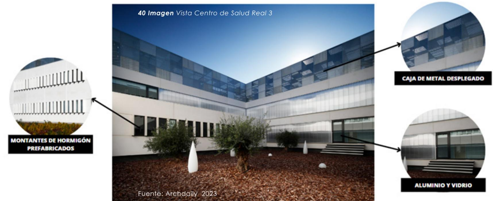
La estructura del proyecto es de hormigón armado, los materiales que se usaron fueron montantes de hormigón armado que se alternan con paneles de vidrio translúcido en las ventanas con el fin de enmarcarlas. Para enfatizar el perfil horizontal se optó
