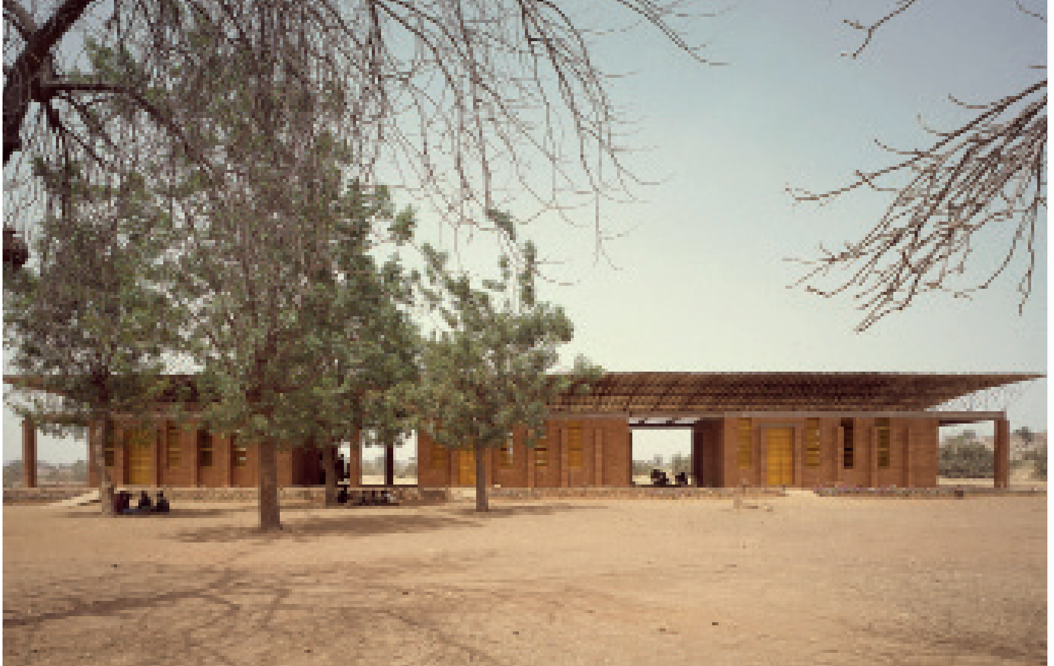
Fig 14: Fachada de Escuela Primaria de Gando
