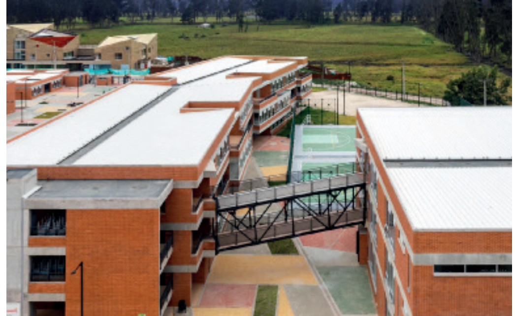
Fig 12: Rampa Los Colegios Campoverde I y II
