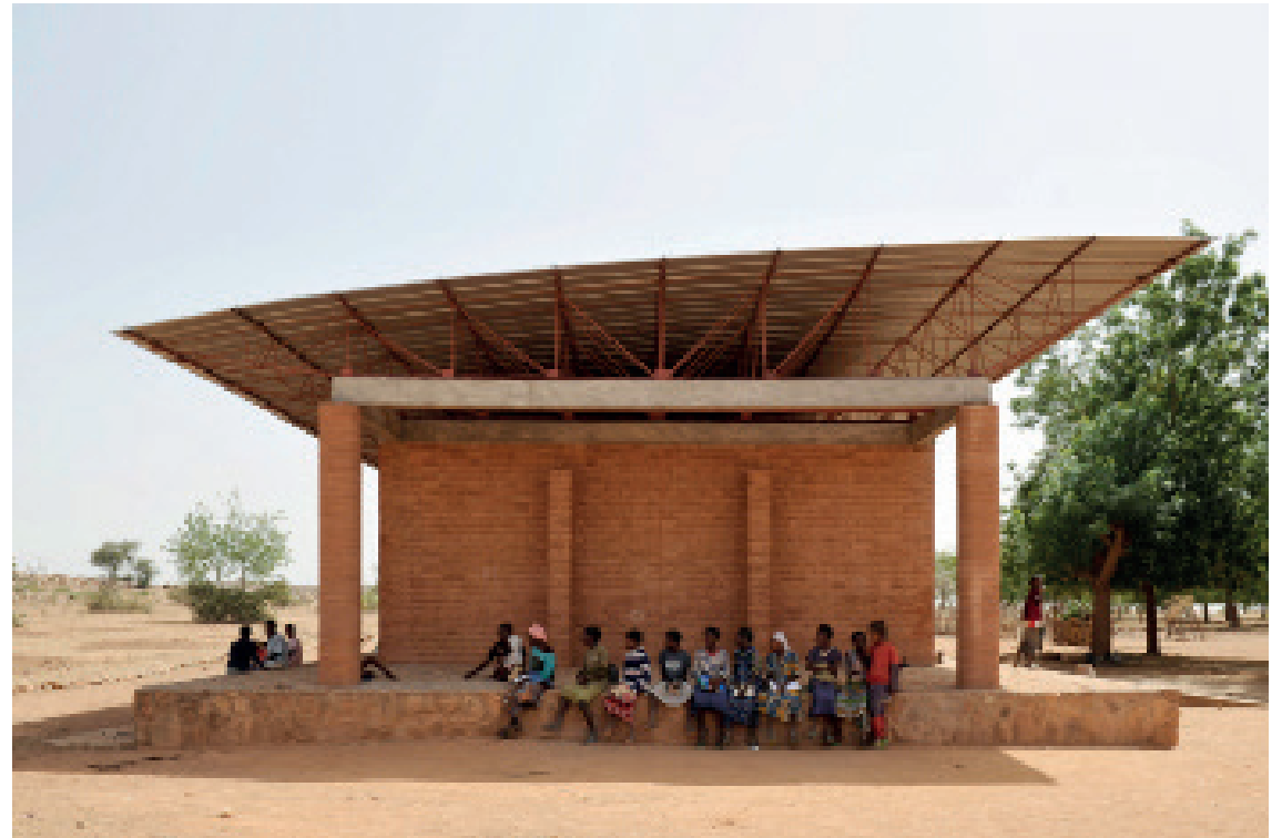
Fig 15: Fachada lateral de Escuela Primaria de Gando
