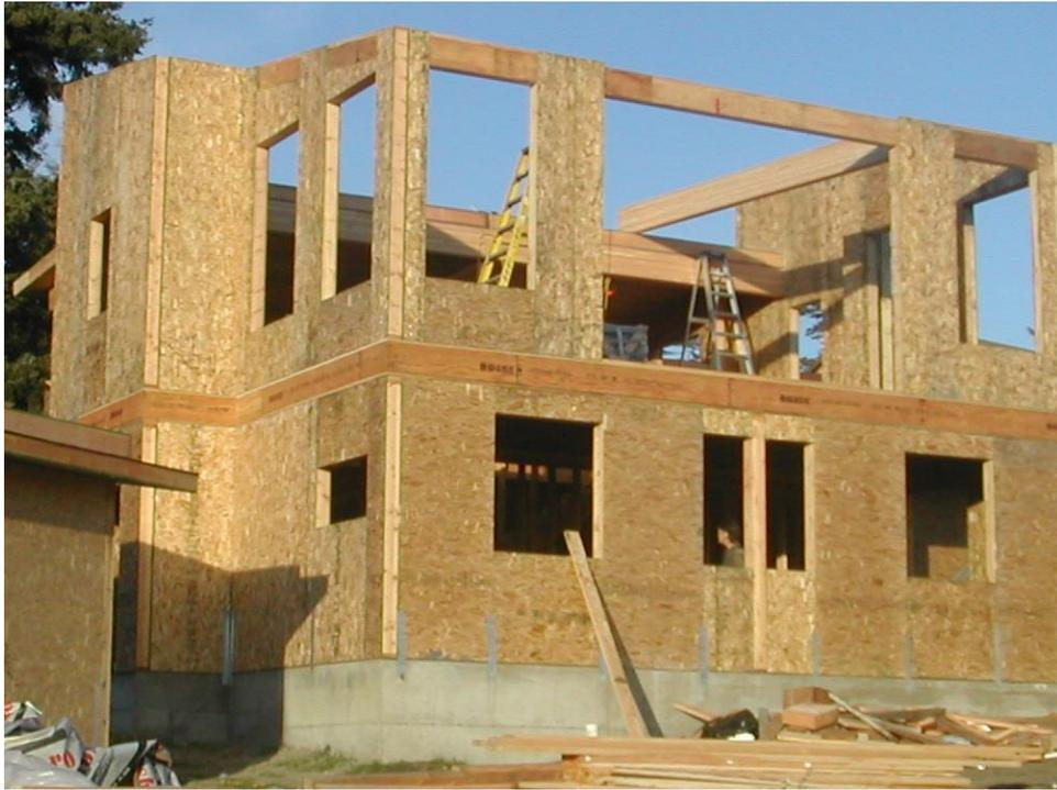
*Ilustración 1. Vivienda construida con paneles SIP.*
