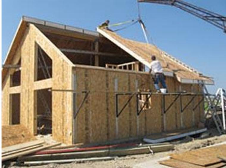
*Ilustración 2. Instalación con paneles de techo.*
