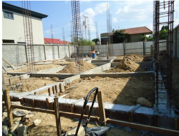
Ilustración 12. Cimentación y armado de columnas
