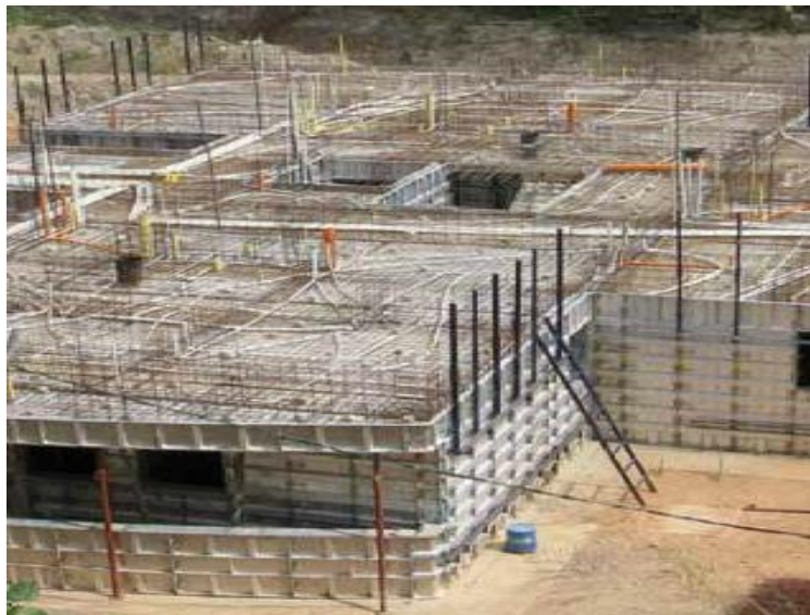
Ilustración 62. Armado de losa
