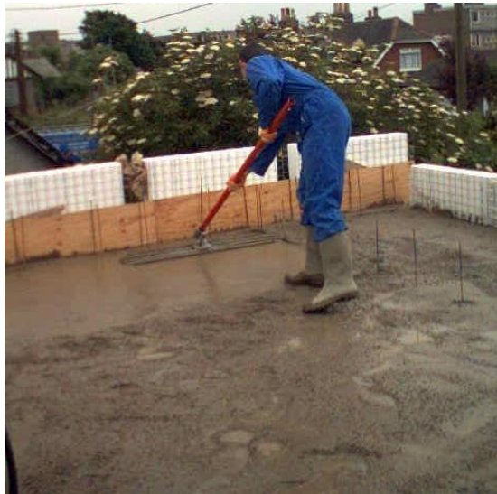
Ilustración 34. Fundición de losa
