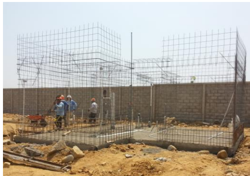
Ilustración 60. Armado de muros
