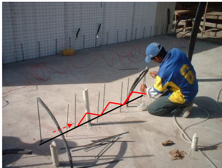
Ilustración 30. Anclajes en contrapiso
