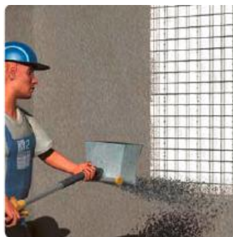
Ilustración 33. Lanzado de hormigón
