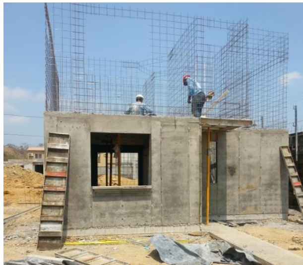
Ilustración 65. Desencofrado
