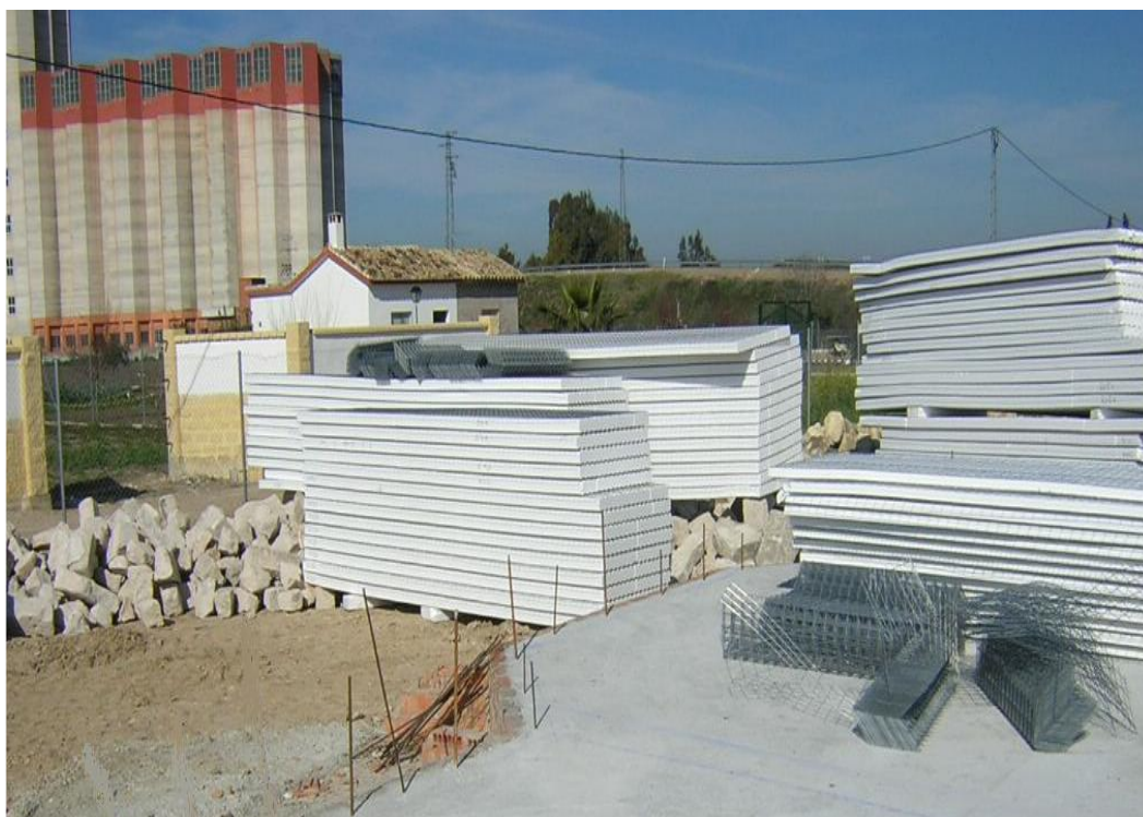
Ilustración 25. Almacenamiento de paneles
