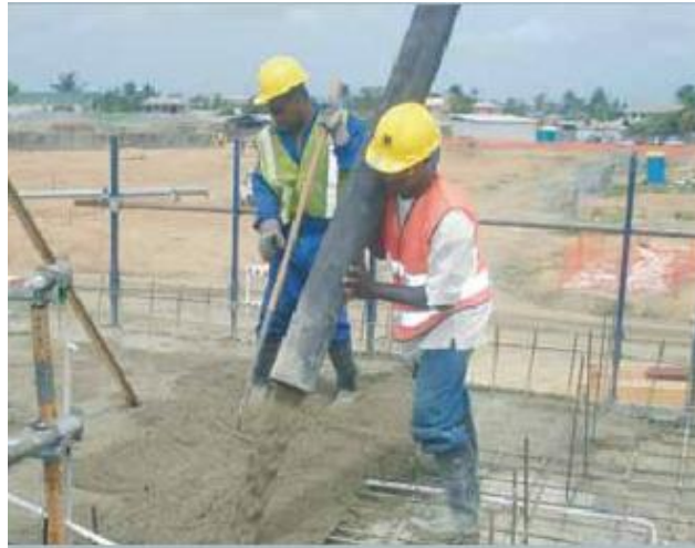
Ilustración 63. Fundición monolítica (muros y losa)
