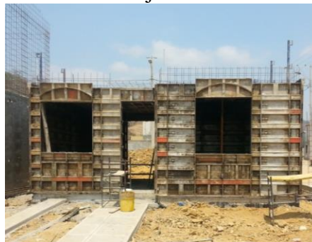
Ilustración 61. Montaje de formaleta de muros
