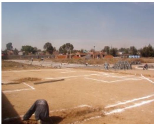
Ilustración 47. Trazado de vivienda
