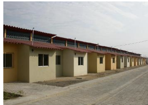
FIGURA 10. VIVIENDAS MODELO MCUHO LOTE I. Recuperado el 3 de Febrero 2012 de: http://www.conbaquerizo.com/index_archivos/DetailfotograficoVillasMuchoLote.htm
