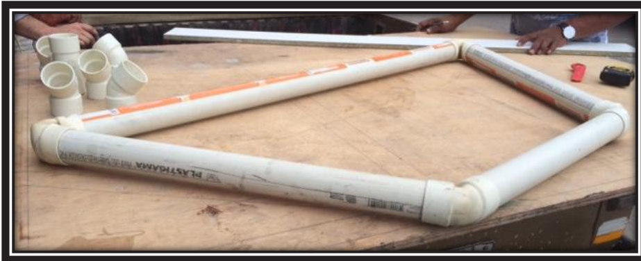
Imagen 35: Trazado, replanteo, estructura de mesa a base de tubería de PVC
