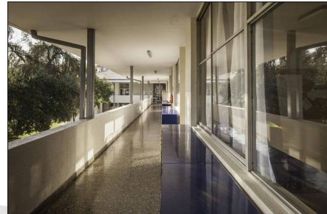
Imagen 26. Vista de corredor con casilleros
