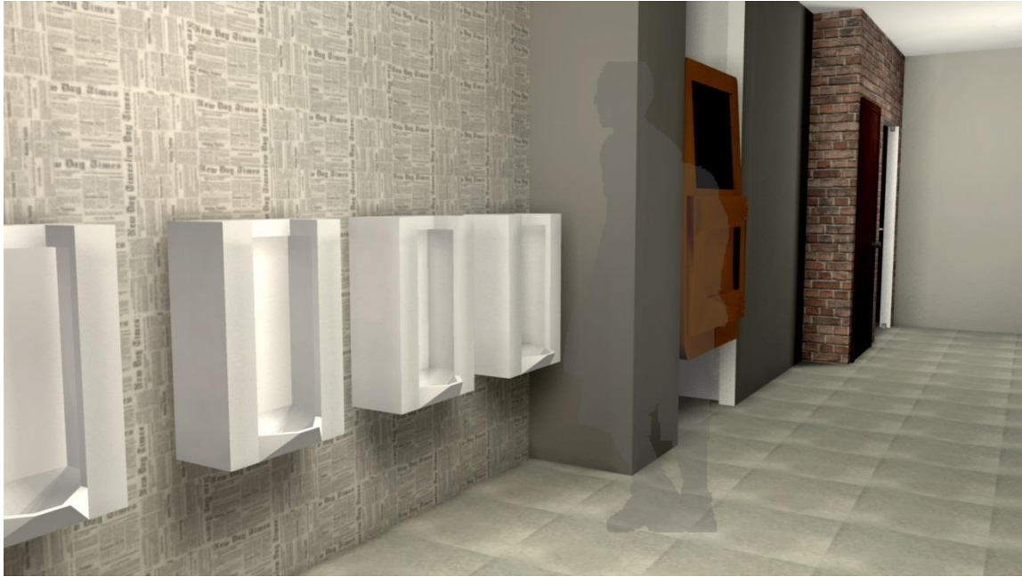
Figura 94. Urinarios de Sanitarios Públicos,
