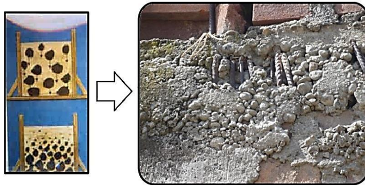
Figura 7 Segregación del Hormigón.
