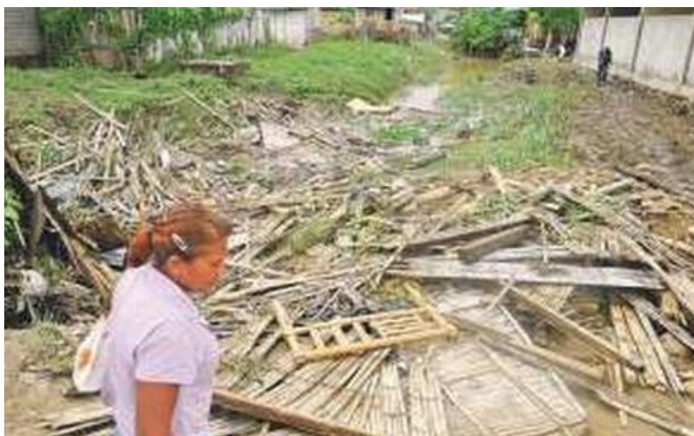
Imagen N° 7.- Colapso de vivienda en la Cooperativa Sergio Toral. Fuente: (Telégrafo, 2013).
