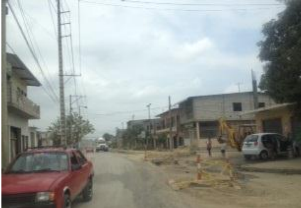
Imagen Nº 6.- Mejorías en Nueva Prosperina. Fuente: Elaboración propia.
