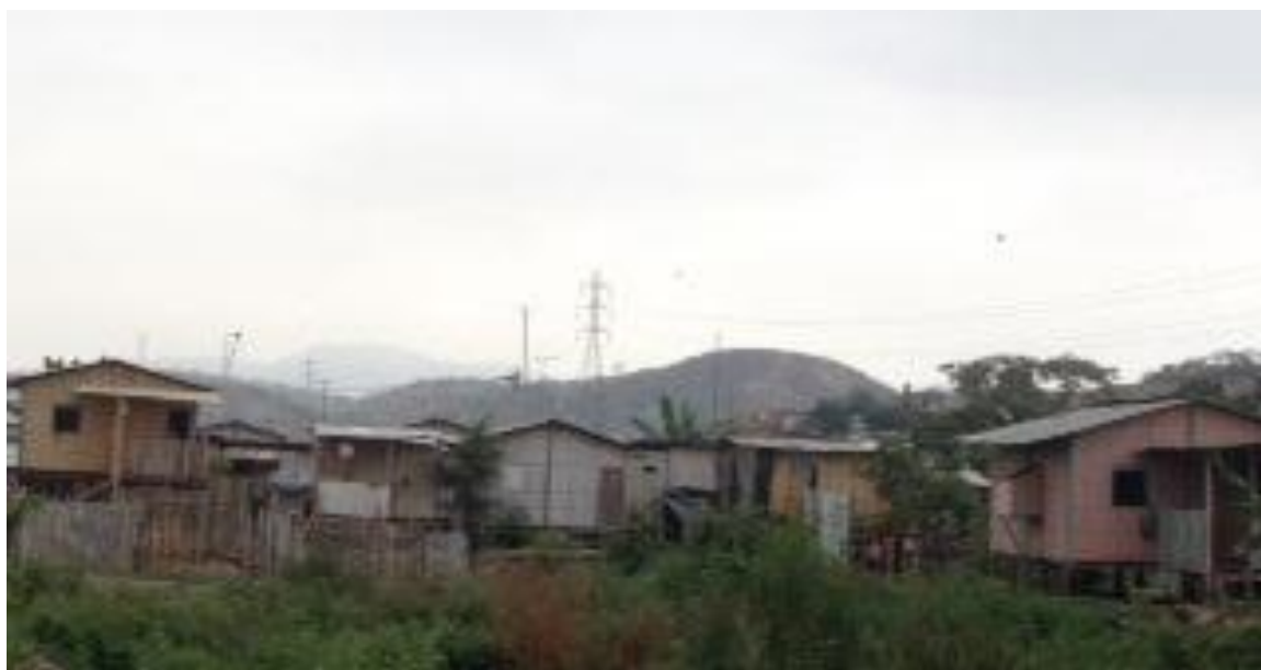
Imagen N° 4.- Viviendas en el sector La Ladrillera.
