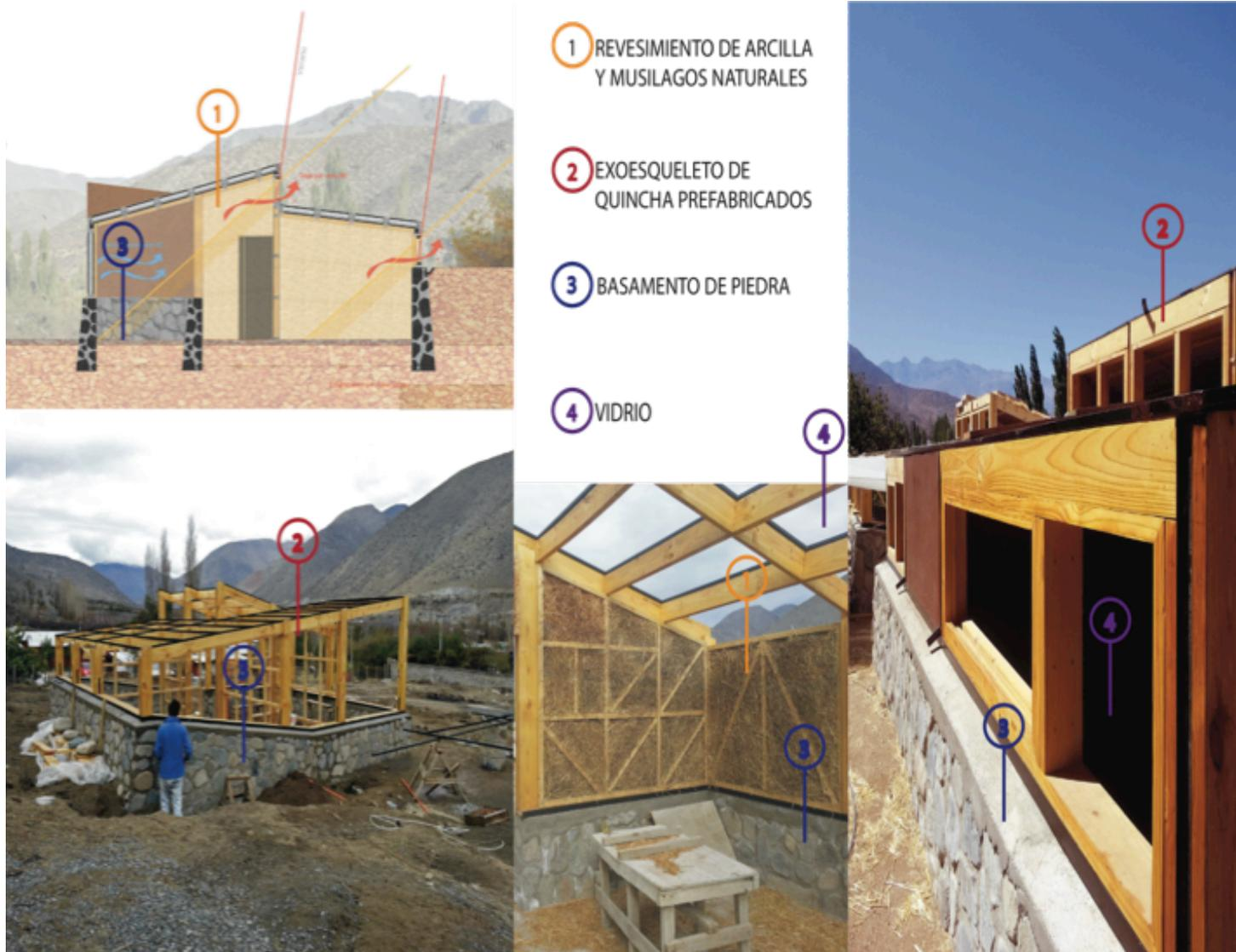
Una de las propuestas expuestas para la construcción de este complejo es la cimentación semienterrada de piedra trabaja como un envolvente y base para cada modulo donde se utiliza. Además usa como material sustentable módulos de quincha recubiertos con arcilla y mucilagos naturales, esto se usa para las paredes y cubierta de cada modulo. Asimismo se pensó en los vientos y se creó vanos donde pueda recorrer y existir una ventilación cruzada (Cabezas, 2013).
