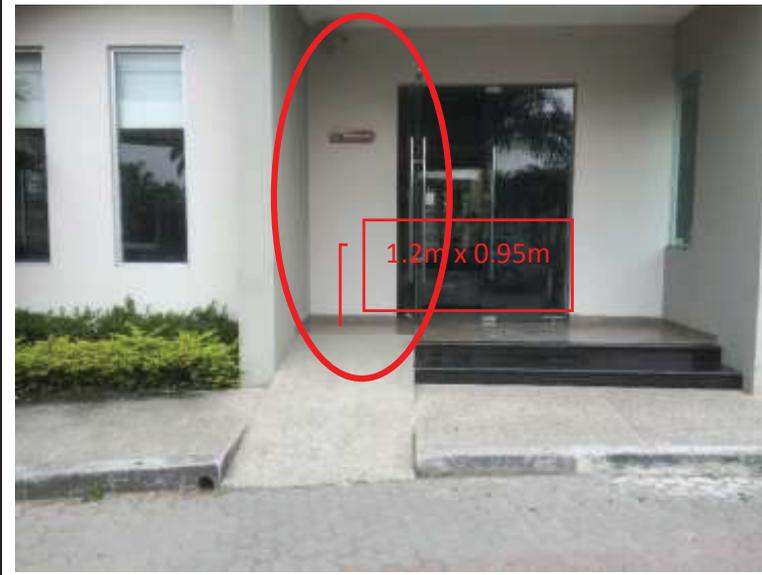
Rampa de acceso en el exterior de la garita principal. La rampa no tiene color ni simbología que la identifique, y el nivel más alto de la rampa llega a un área de difícil maniobra ya que está en contra de la apertura de la puerta.
