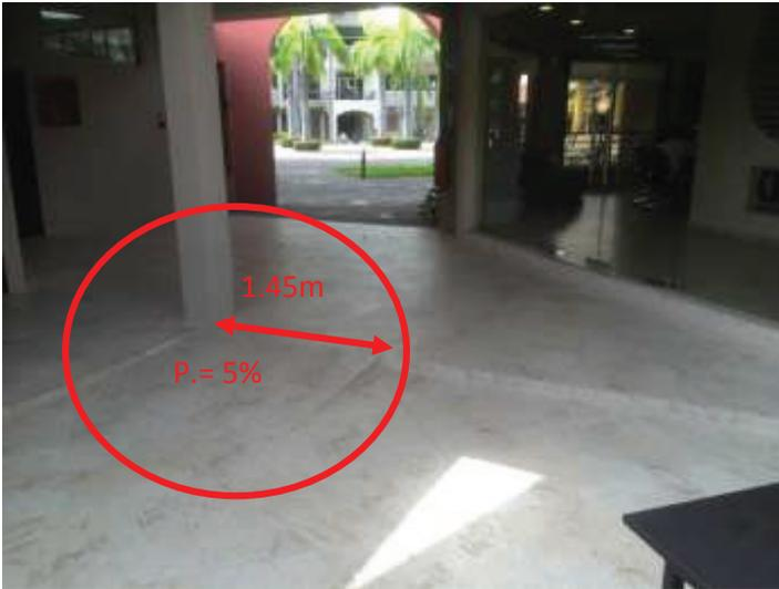
Rampa 2. En el patio central de las aulas de ingeniería tiene un nivel deprimido del resto de la circulación, cuenta con una rampa de acceso con pendiente de 5% y con un ancho de 2.45m necesario para cumplir con la normativa, pero es difícil identificarla ya que esta echa del mismo material del piso a su alrededor sin color ni simbología alguna y sin textura antideslizante.
