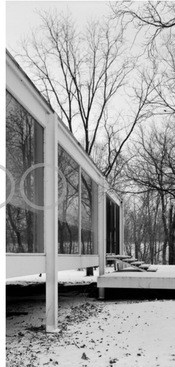
IMAGEN 19: Casa Farnsworth FUENTE: (CaViCa, 2010)
