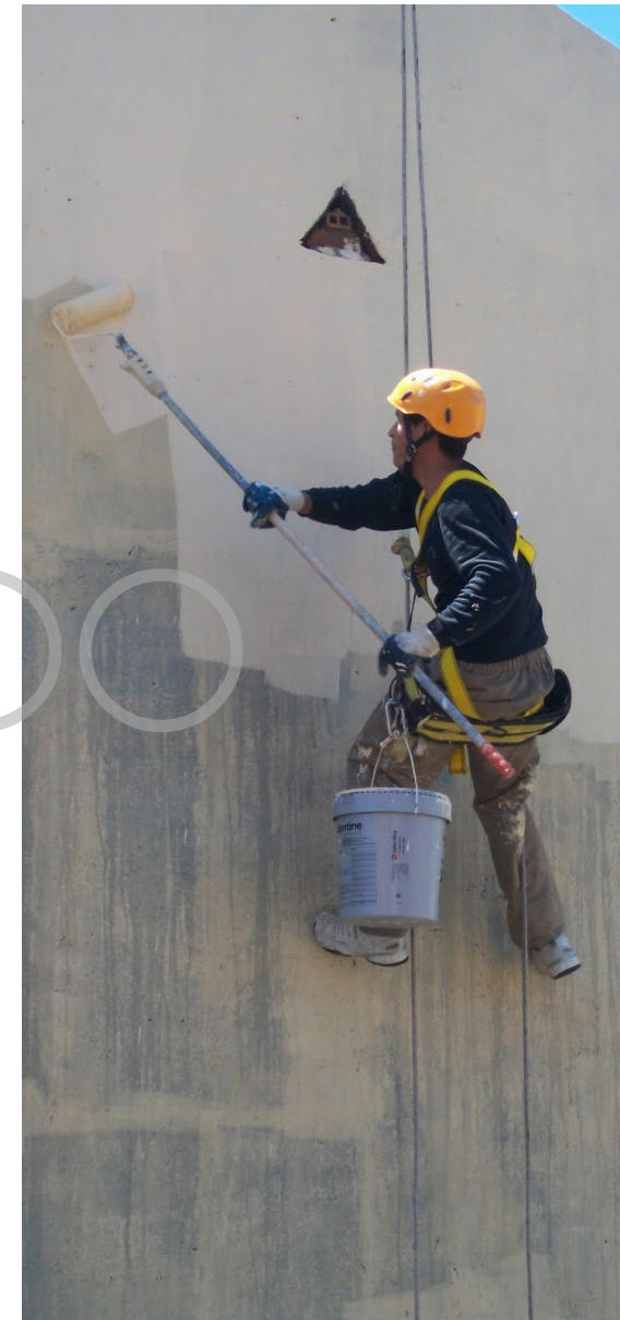
IMAGEN 108: Mantenimiento a fachada de edificio Fuente: (JMG, 2013)
