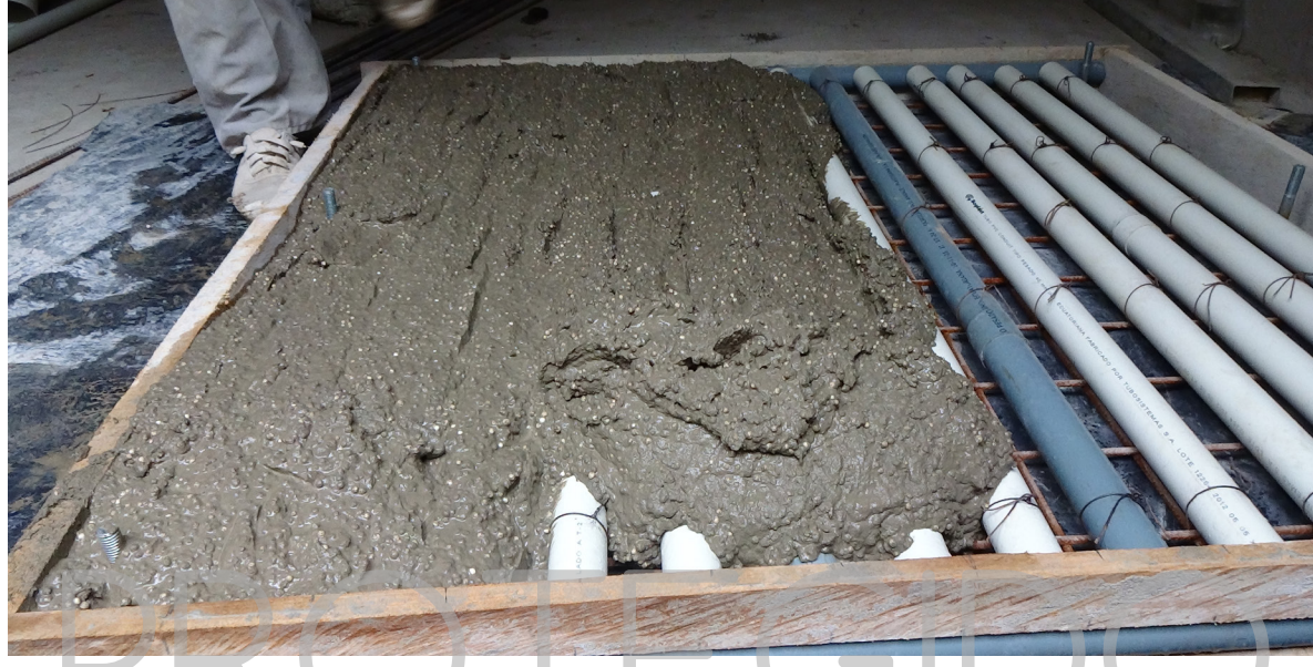
IMAGEN 235: Encolado del hormigón en la pieza de encofrado Fuente: Realizado por Denisse Aguilera
