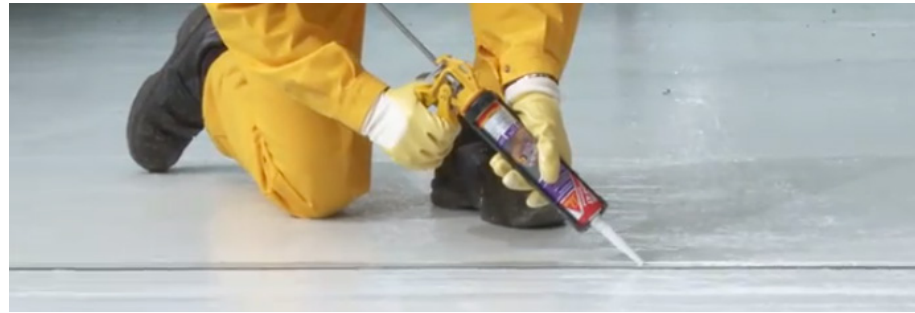
IMAGEN 174: Sellado de junta con poliuretano Fuente: (ImageStormsStudios, 2011)
