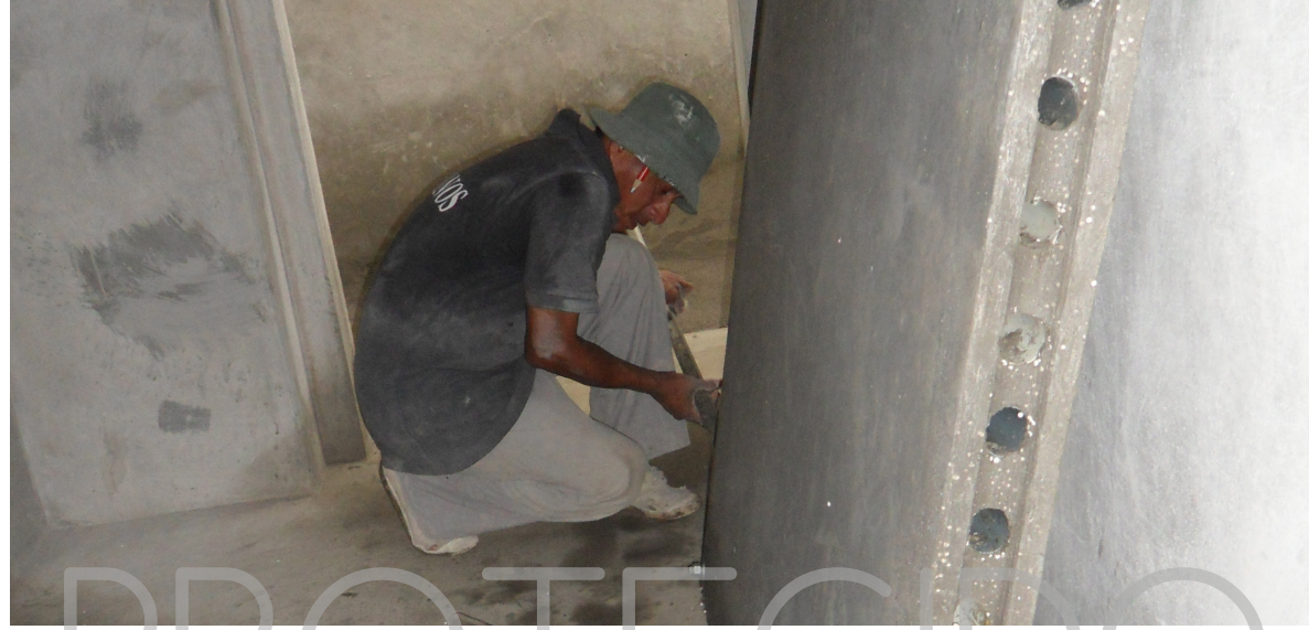
IMAGEN 242: Destapamiento de tubos de PVC Fuente: Realizado por Denisse Aguilera
