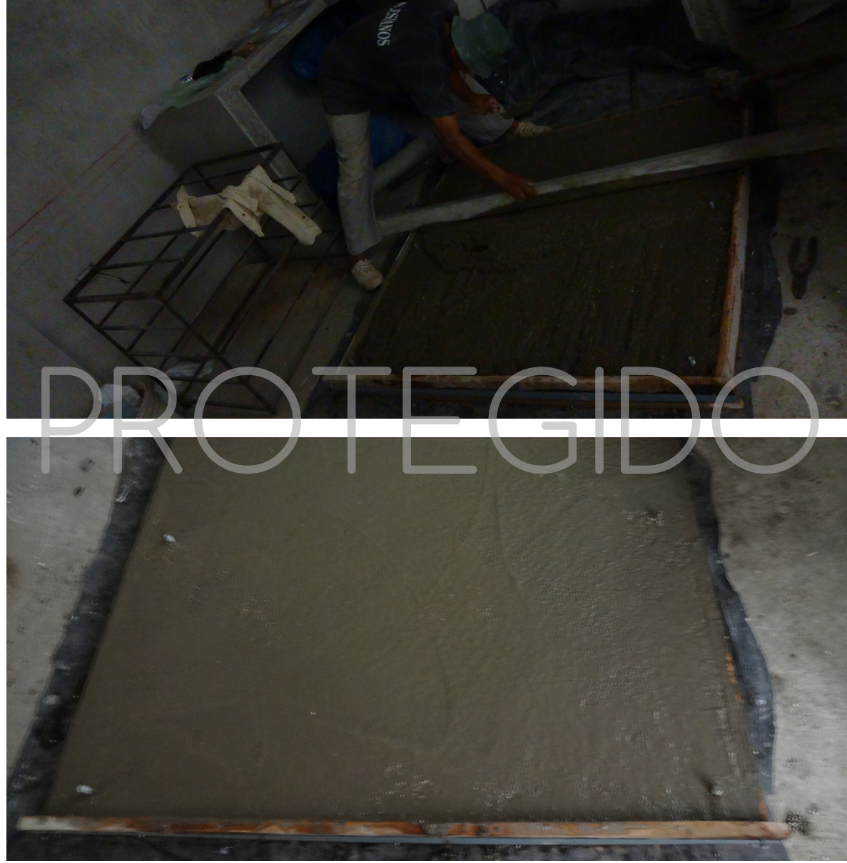
IMAGEN 238: Panel de hormigón aligerado listo para su etapa de endurecimiento Fuente: Realizado por Denisse Aguilera
