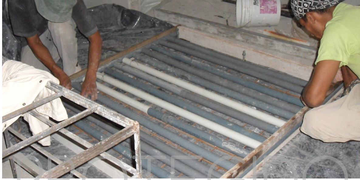
IMAGEN 225: Ubicación de los pernos en el encofrado del panel prefabricado Fuente: Realizado por Denisse Aguilera
