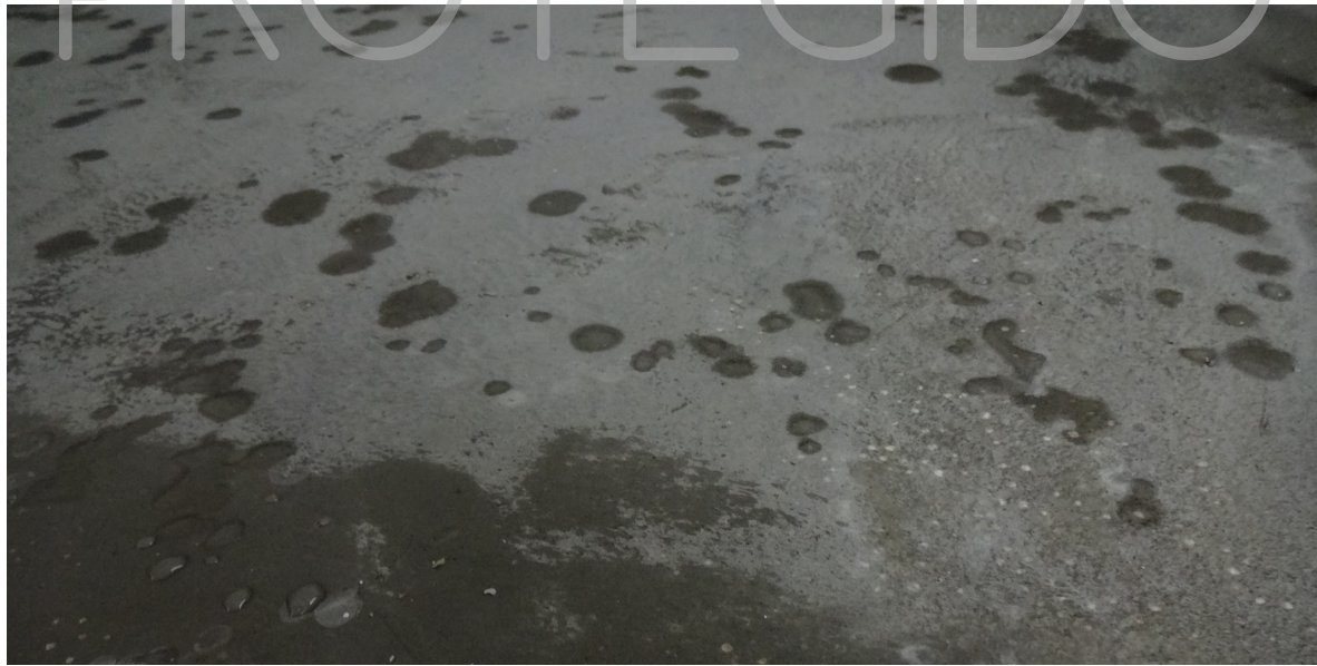
IMAGEN 246: Hormigón hidratado luego de curado Fuente: Realizado por Denisse Aguilera
