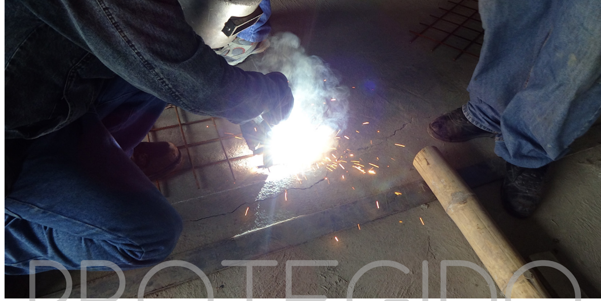
IMAGEN 211: Soldadura de pieza en L o malla metálica Fuente: Realizado por Denisse Aguilera
