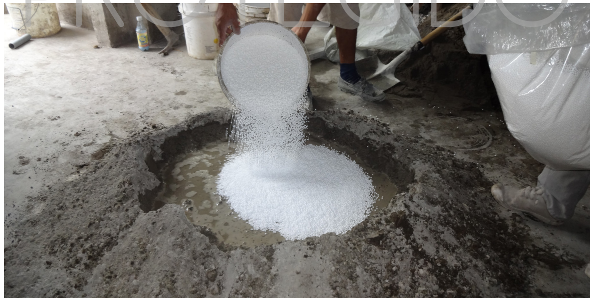
IMAGEN 231: Adición de micro-perlita de poliestireno expandido Fuente: Realizado por Denisse Aguilera
