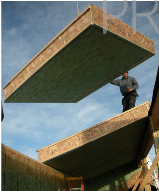
IMAGEN 14: Panel de madera con material aislante FUENTE: (Madeen Architecture & Construction, LLC, 2012)
