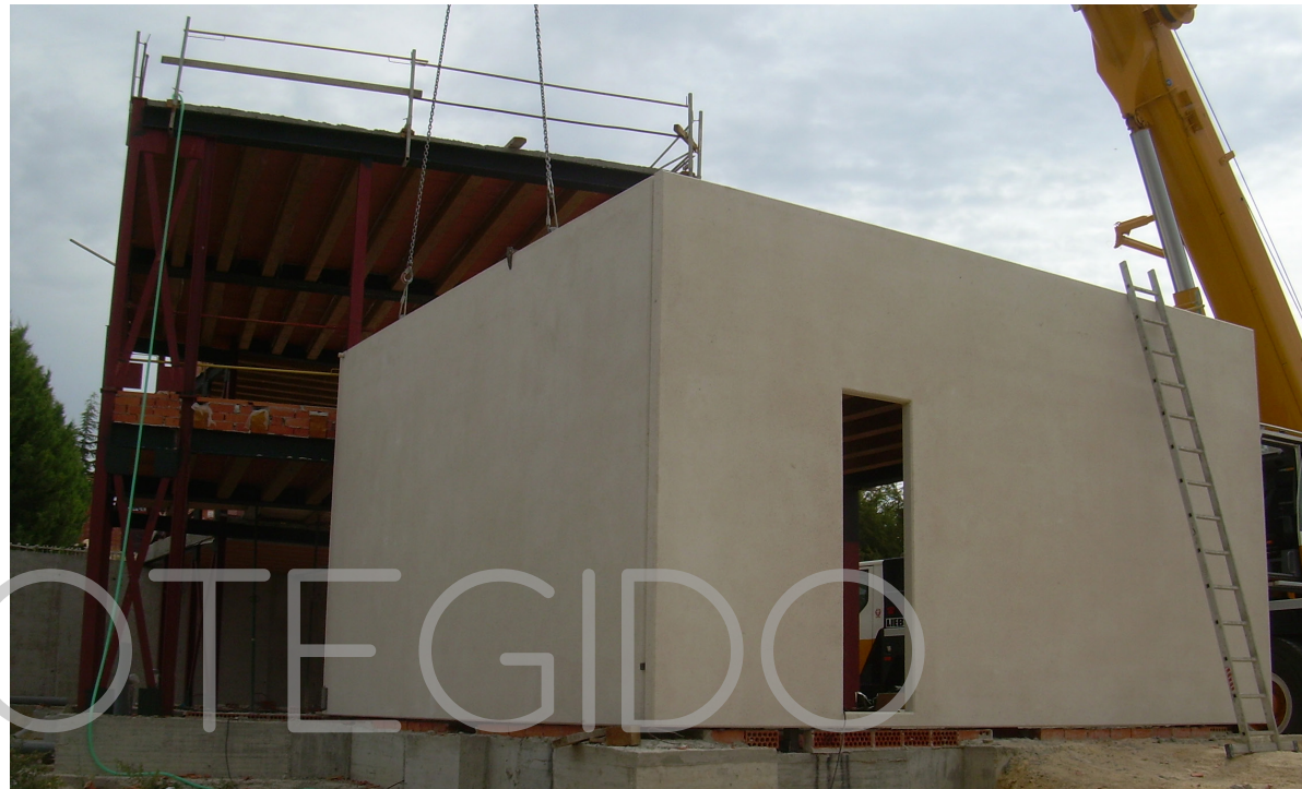
IMAGEN 75: Prefabricación, puesta en obra Fuente: (Prehorquiza, 2012)
