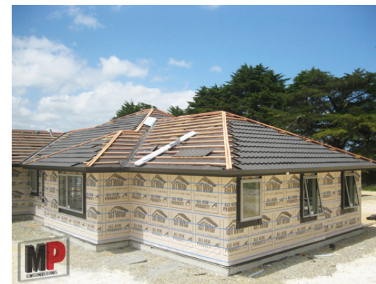
IMAGEN 57: Montaje de paneles metálicos en vivienda Fuente: (Marco Polo Engineering, 2012)
