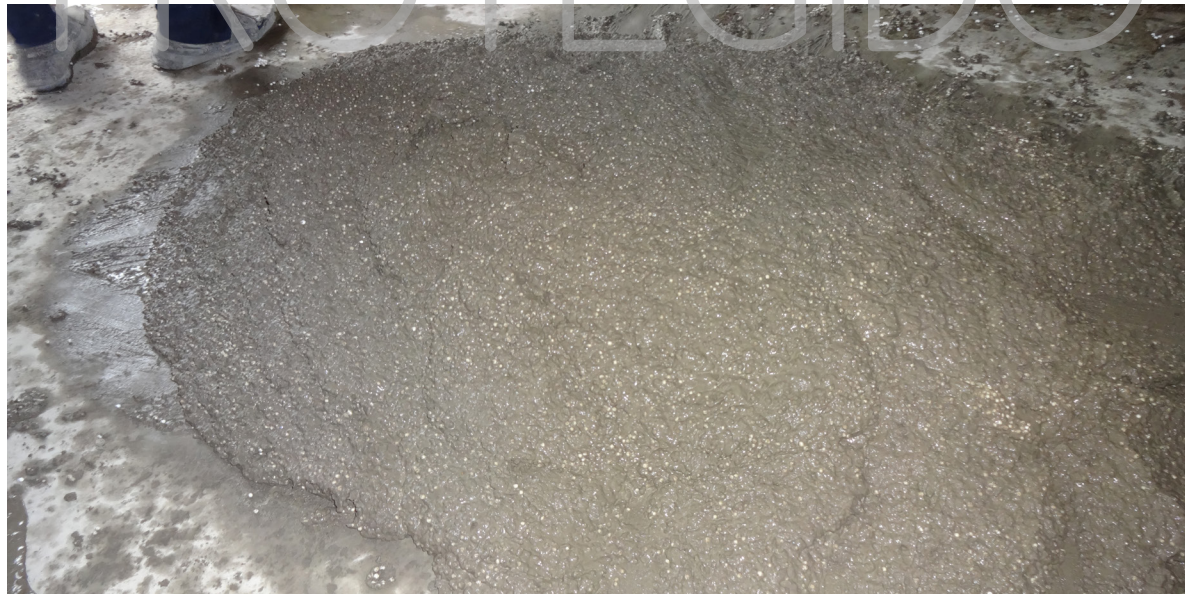
IMAGEN 233: Mezcla lista de hormigón aligerado con micro- perlita de poliestireno expandido Fuente: Realizado por Denisse Aguilera
