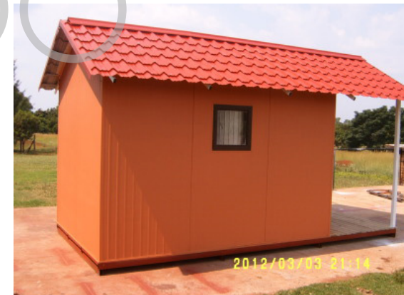
IMAGEN 54: Casa realizada con panel AR-2000 Fuente: (JunkMail, 2012)
