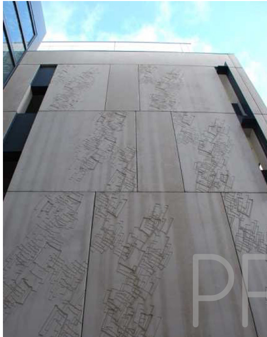
IMAGEN 73: Porosidad hormigón endurecido Fuente: (Prehorquiza, 2012)
