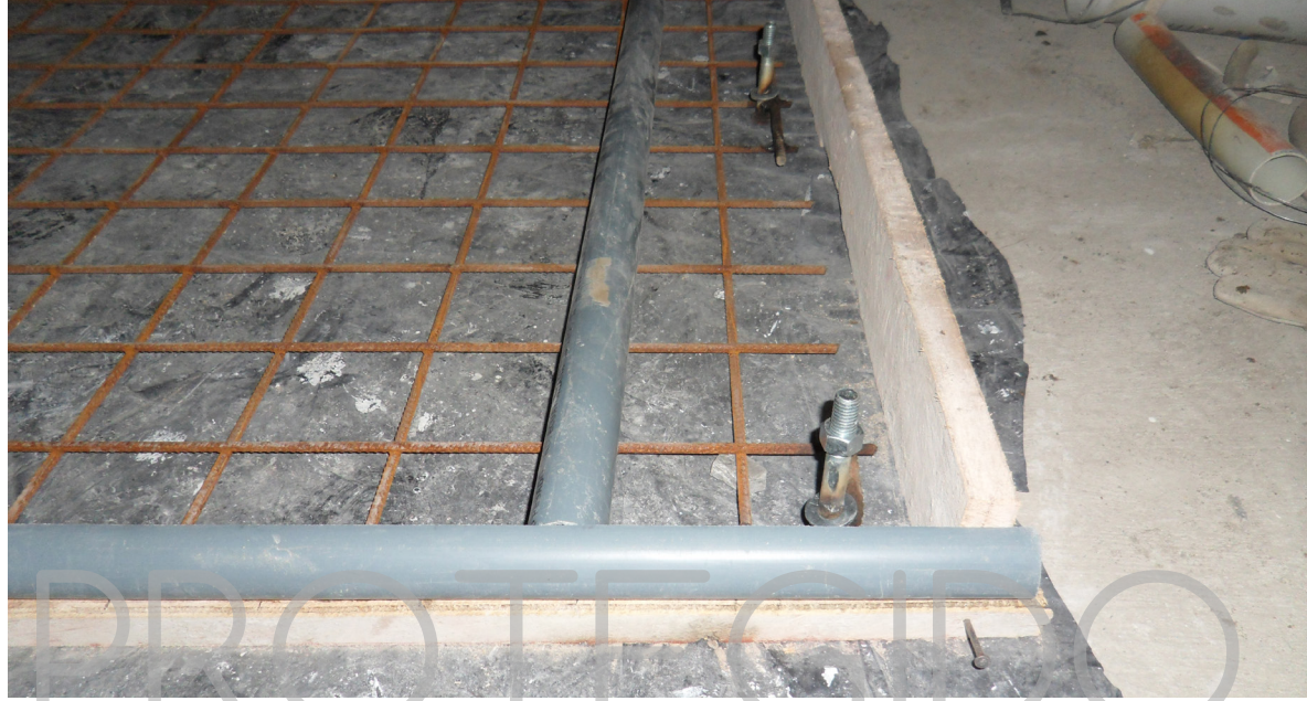
IMAGEN 220: Colocación de mediacaña de PVC en encofrado de madera Fuente: Realizado por Denisse Aguilera
