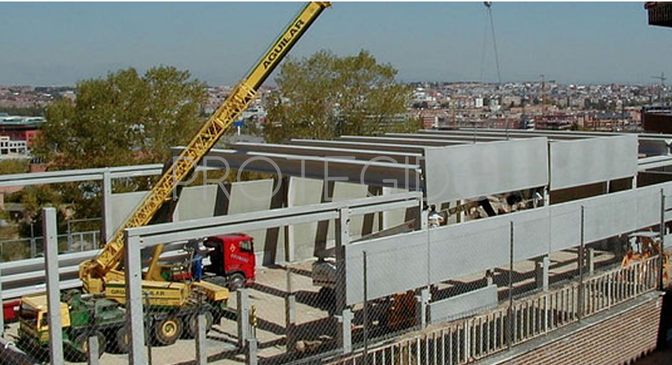
IMAGEN 12: Prefabricación para cerramiento de fachada Fuente: (Hormipresa, 2011)
