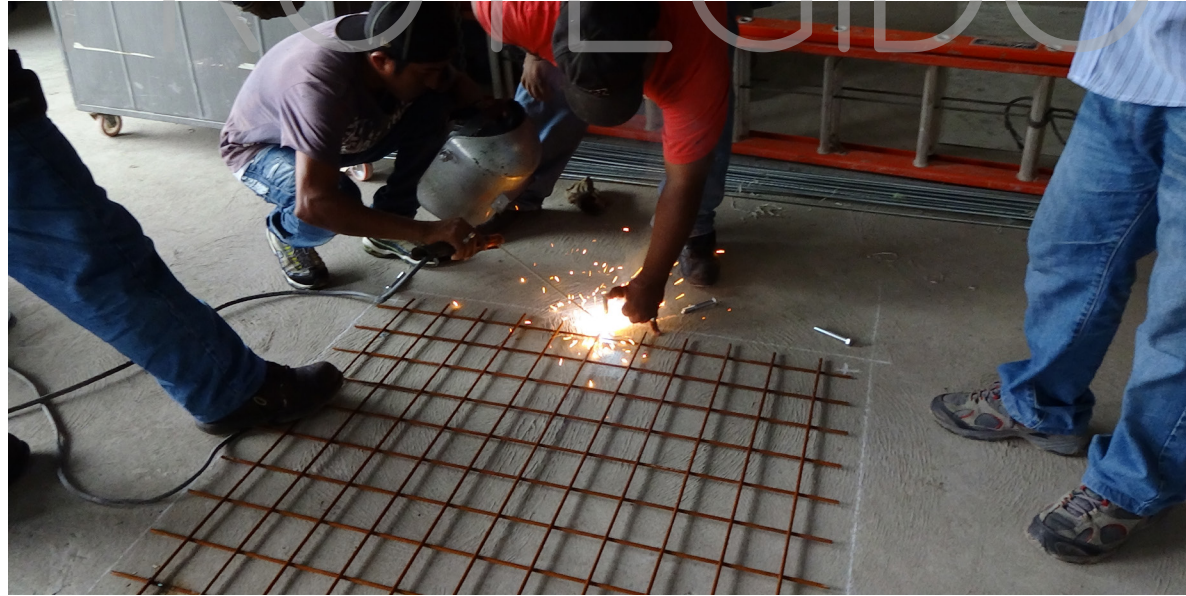
IMAGEN 208: Soldadura de pernos a malta electro-soldada Fuente: Realizado por Denisse Aguilera
