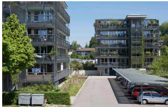
IMAGEN 87: Edificio de departamentos con acabado en acero Fuente: (Infante, 2009)
