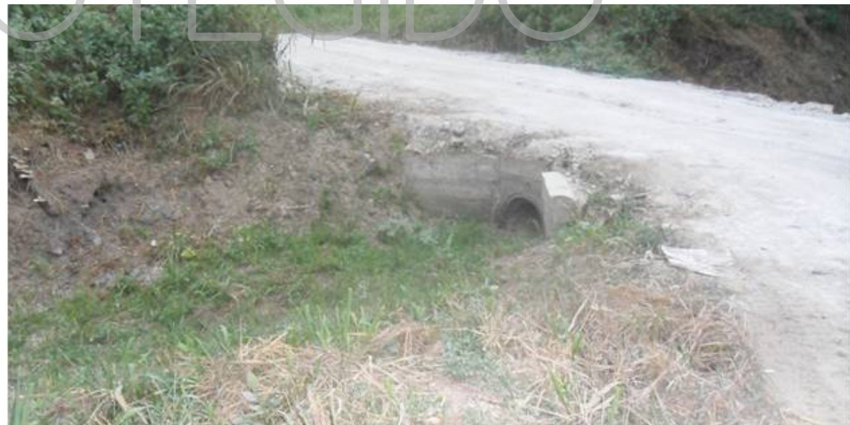
IMAGEN 362: Canal de AALL ubicado en el frente del terreno Fuente: Fotografía tomada por Denisse Aguilera
