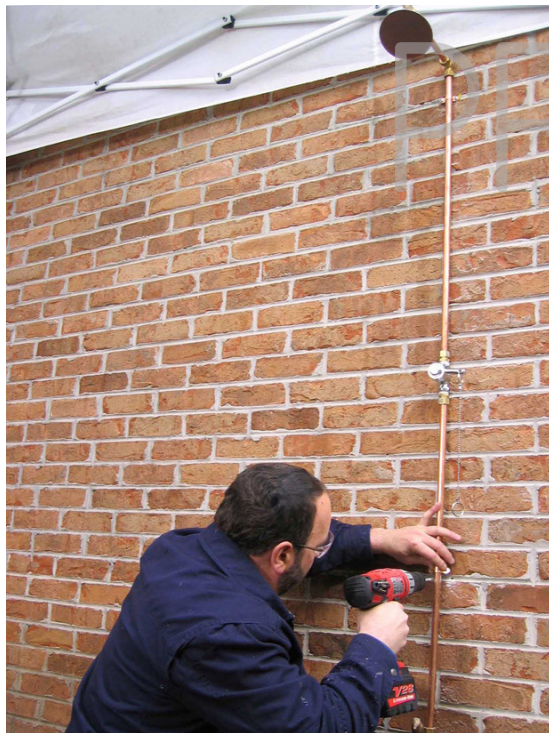
IMAGEN 184: Tubería sujeta por anclaje Fuente: (DIY Network, 2010)
