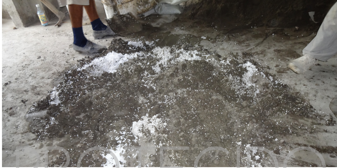
IMAGEN 232: Empalado de agregados de hormigón aligerado Fuente: Realizado por Denisse Aguilera
