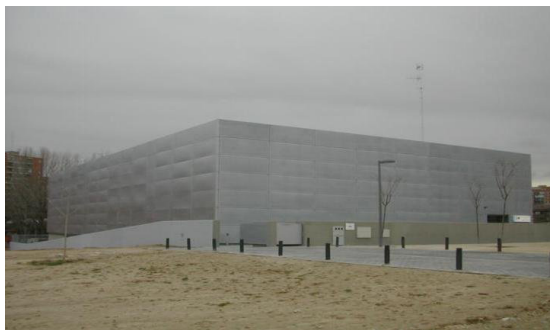
IMAGEN 48: Planchas de acero galvanizado en Fachada - Centro de Salud "La Rivota", Madrid Fuente: (Asociación Técnica Española de Galvanización, s/f)
