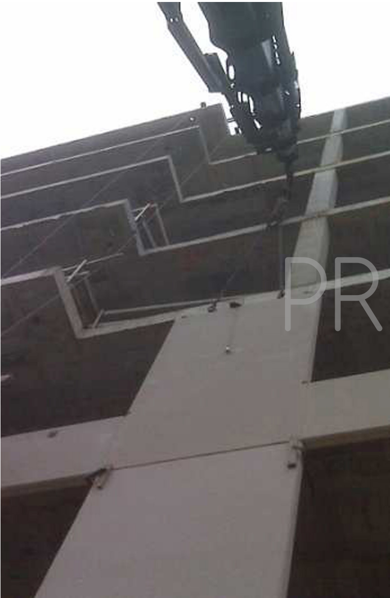
IMAGEN 69: Montaje de panel Fuente: (Prehorquisa, 2012)
