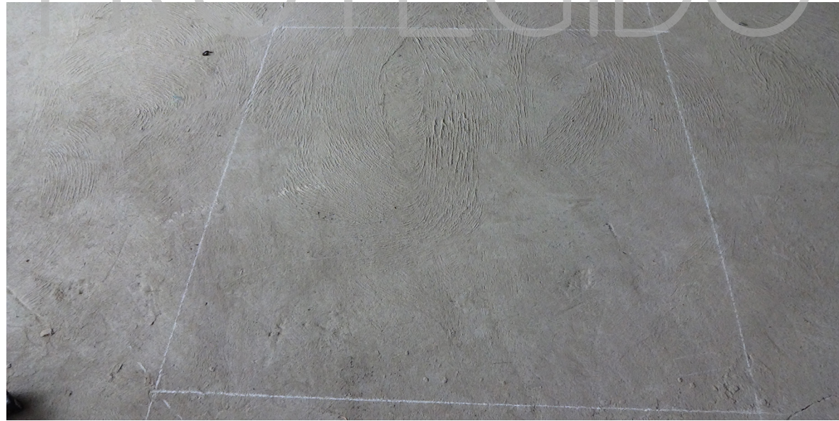
IMAGEN 204: Trazado de marco de panel en superficie. Fuente: Realizado por Denisse Aguilera
