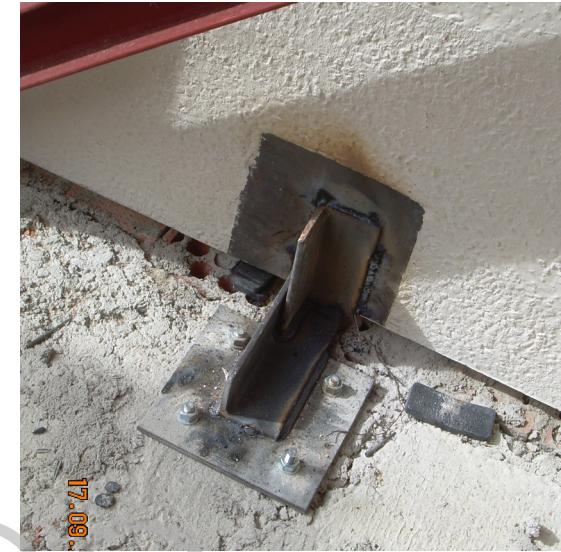
IMAGEN 119: Sujeción metálica a losa de hormigón Fuente: (Prehorquiza,2012)
