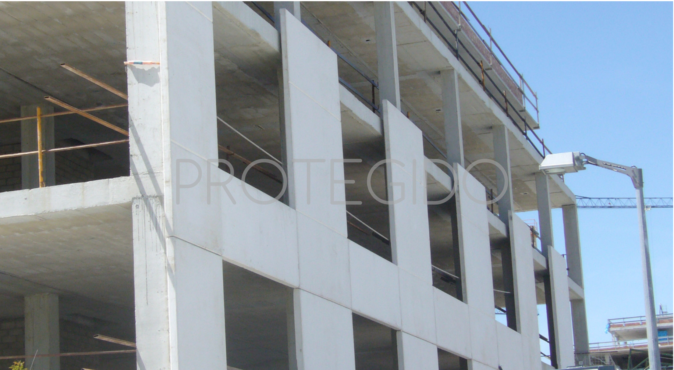
IMAGEN 111: Montaje en obra de paneles prefabricados de hormigón Fuente: (RTVN, 2011)
