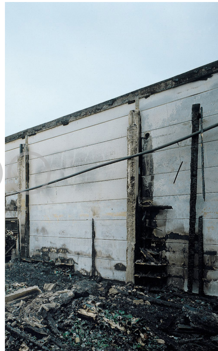
IMAGEN 100: Resistencia al fuego del hormigón Fuente: (HCA Chile S.A., 2013)
