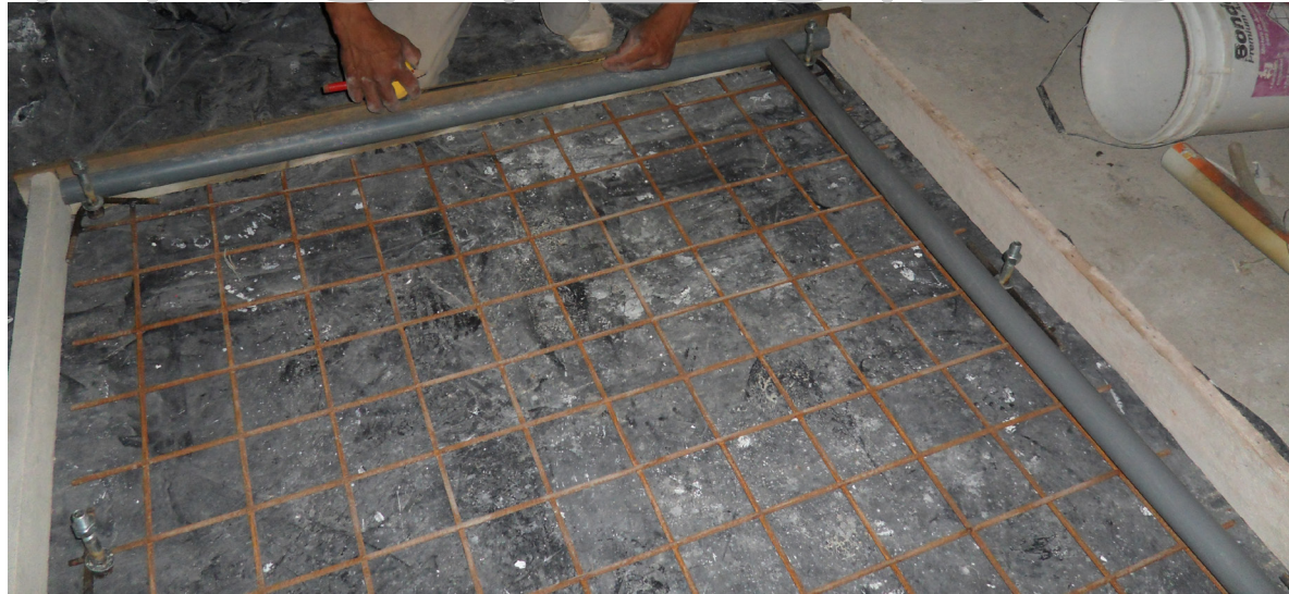
IMAGEN 221: Colocación de mediacaña convexa en encofrado Fuente: Realizado por Denisse Aguilera
