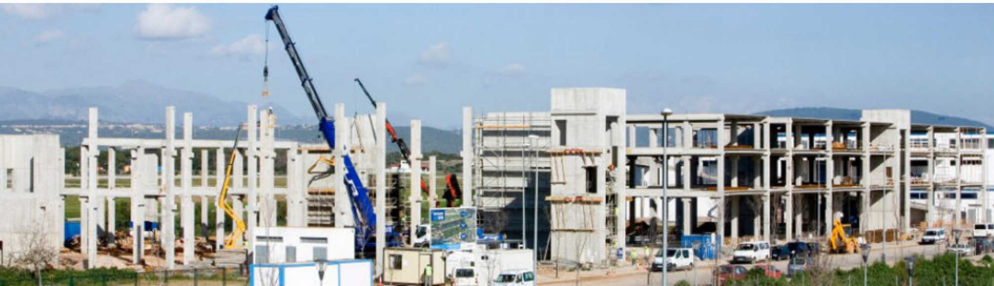
IMAGEN 102. Rapidez constructiva de los paneles prefabricados Fuente: (Tubos y Bloques Fidi, 2012)
