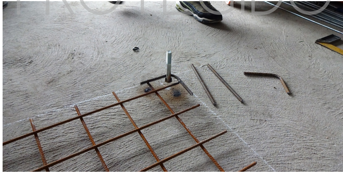
IMAGEN 212: Perno soldado a pieza en L Fuente: Realizado por Denisse Aguilera
