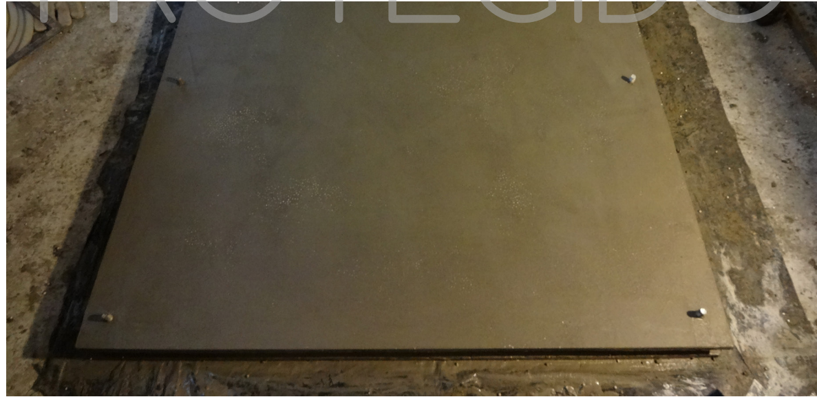
IMAGEN 243: Desencofrado de aristas con mefacañas Fuente: Realizado por Denisse Aguilera
