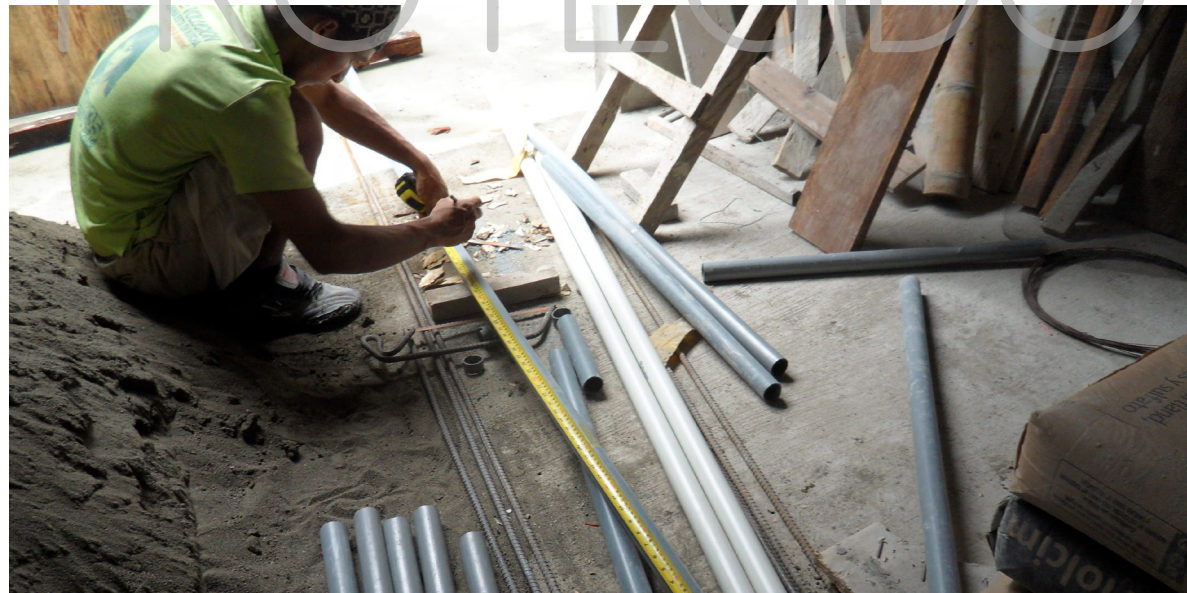
IMAGEN 222: Medición de los tubos a las dimensiones dadas en planos de detalle Fuente: Realizado por Denisse Aguilera
