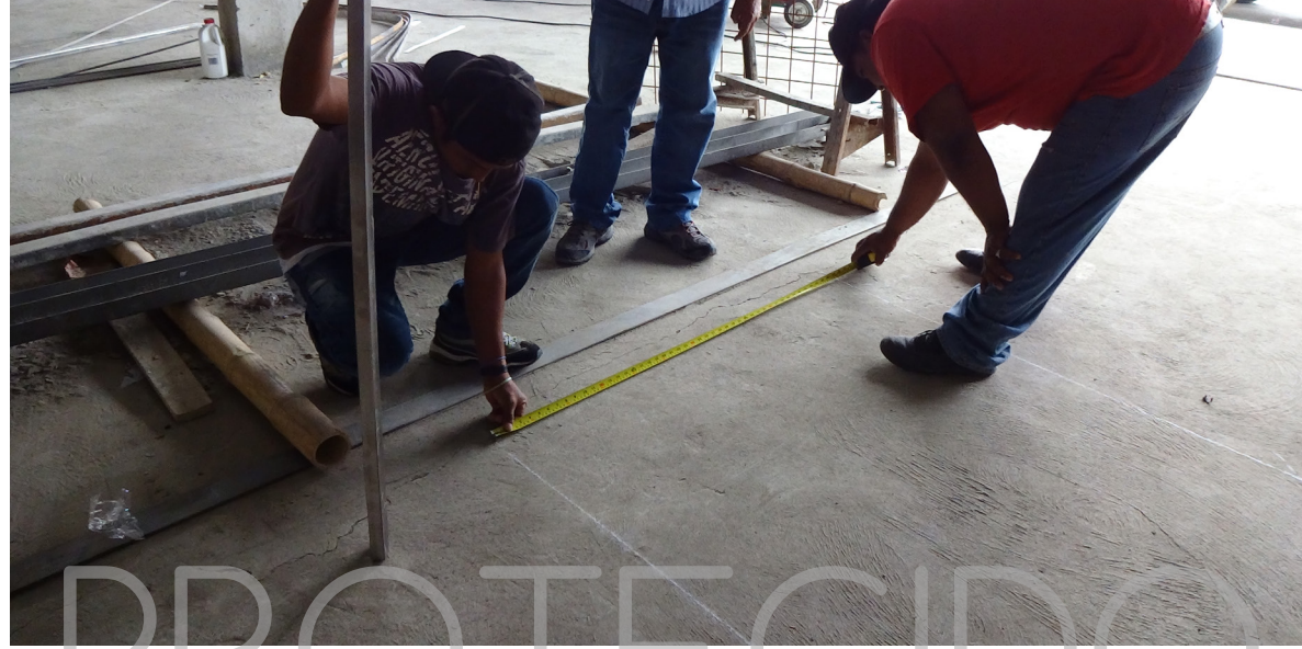
IMAGEN 203: Trazar en superficie limpia y nivelada el marco del panel. Fuente: Realizado por Denisse Aguilera
