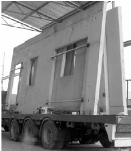
IMAGEN 250: Transporte de panel prefabricado Fuente: (Prehorquisa, 2012)
