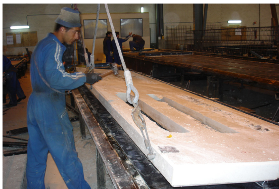
IMAGEN 65: Endurecimiento del hormigón Fuente: (Prehorquisa, 2012)
