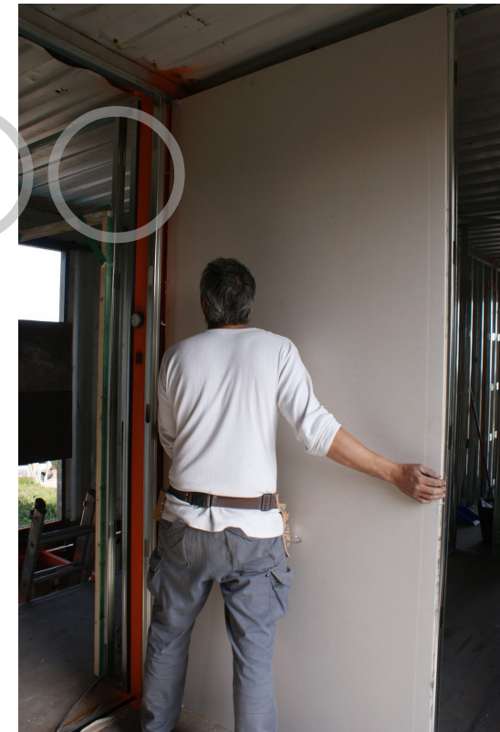
IMAGEN 178: Instalación de panel prefabricado de yeso Fuente: (Contieneunacasa.com, 2011)
