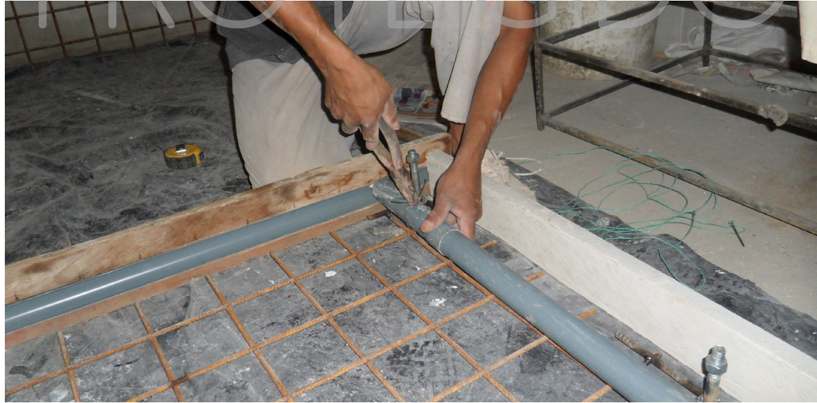
IMAGEN 226: Ubicación de los pernos en el encofrado del panel prefabricado Fuente: Realizado por Denisse Aguilera
