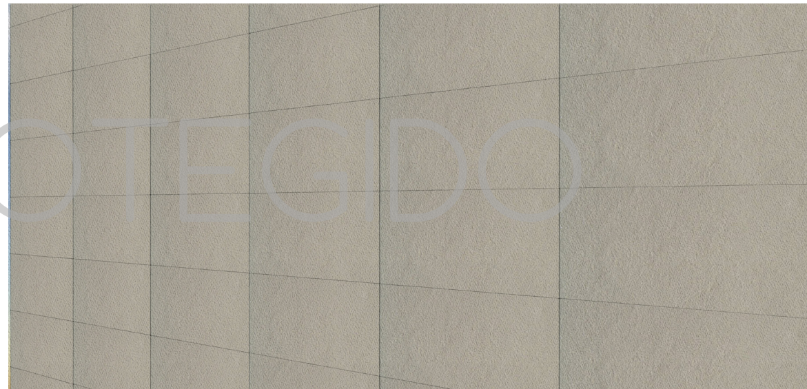
IMAGEN 258: Panel prefabricado de hormigón con las dimensiones propuestas 60x60 cms Fuente: Realizado por Denisse Aguilera
