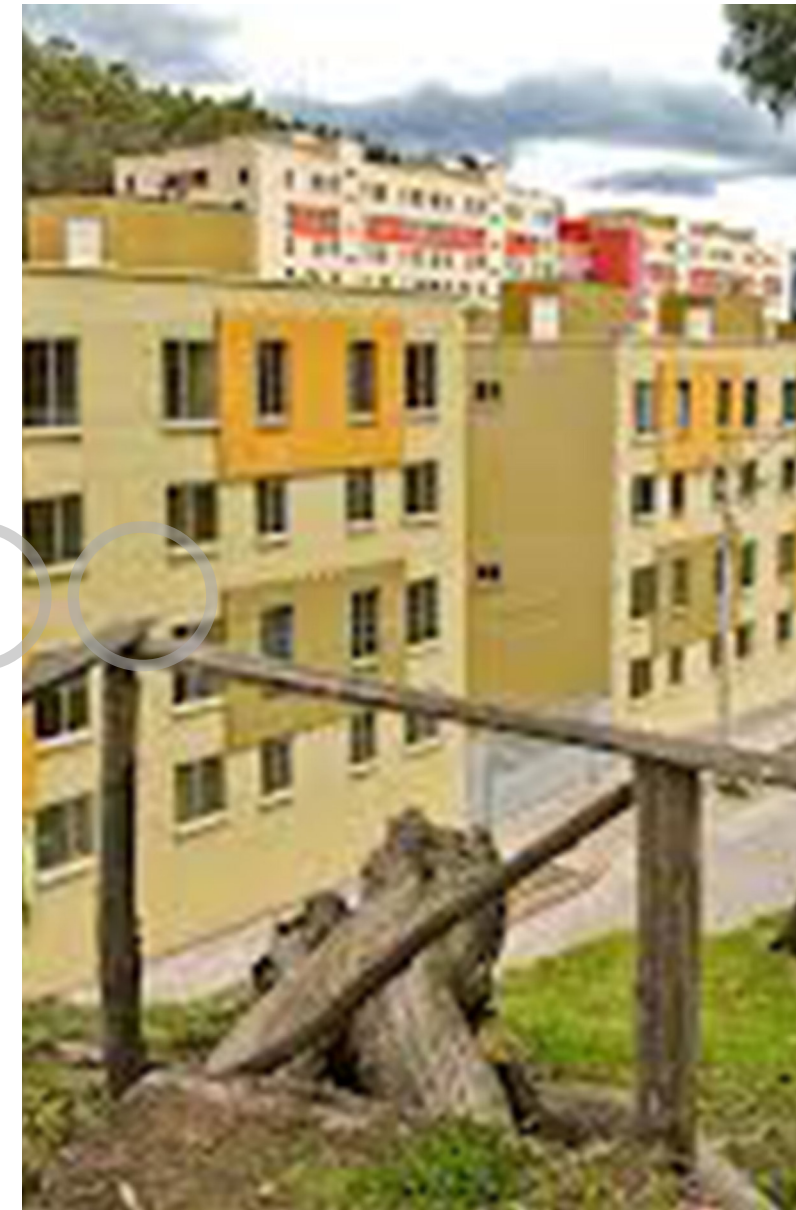
IMAGEN 283: Vista hacia área de departamentos Ciudad Jardín Fuente: (Ciudad Jardín: Conjunto Residencial, 2012)
