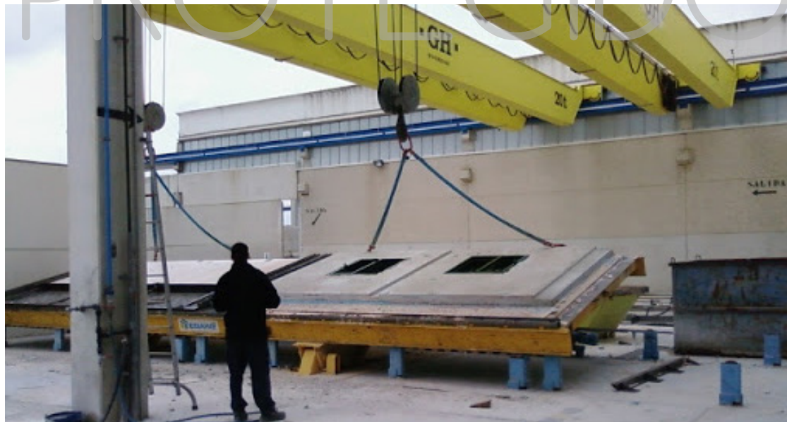
IMAGEN 254: Alzado en obra por medio de grúas Fuente: (Prehorquisa, 2012)
