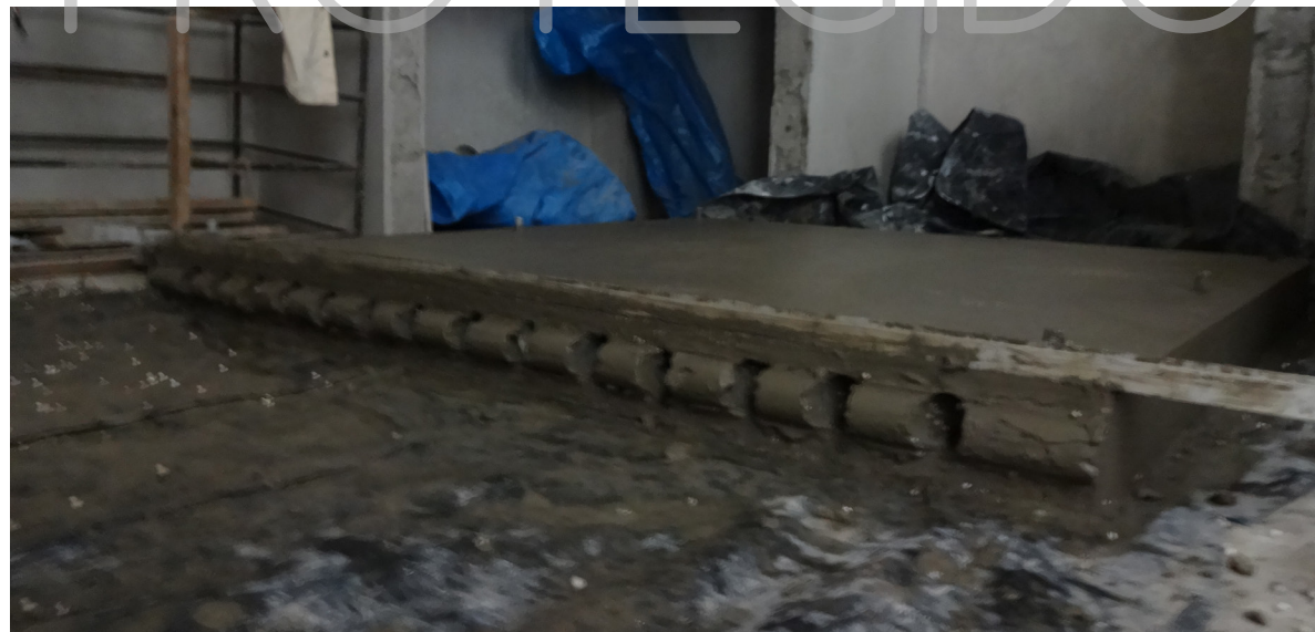
IMAGEN 239: Desencofrado de aristas con mediacañás Fuente: Realizado por Denisse Aguilera
