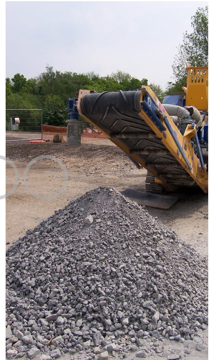
IMAGEN 62: Agregados en hormigón Fuente: (Perrior, 2012)
