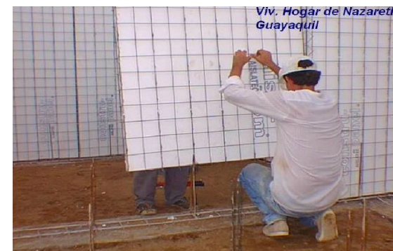
IMAGEN 86: Montaje de panel Fuente: (AISLAPOL, 2009)
