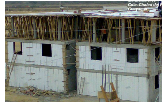
IMAGEN 84: Construcción con Construpanel Fuente: (AISLAPOL, 2009)
