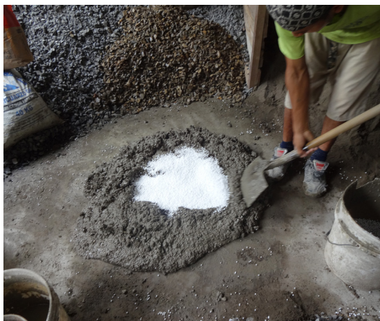
IMAGEN 116: Preparación de hormigón aligerado con microperlita de poliestireno expandido Fuente: Fotografía tomada por Denisse Aguilera
