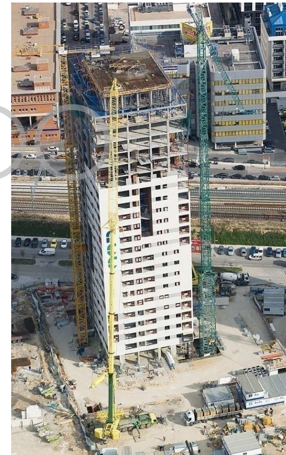
IMAGEN 80: Montaje en obra de sistema prefabricado Fuente: (Prehorquisa, 2012)
