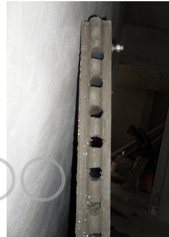
IMAGEN 257: Panel prefabricado de hormigón previo a arreglo manual Fuente: Realizado por Denisse Aguilera
