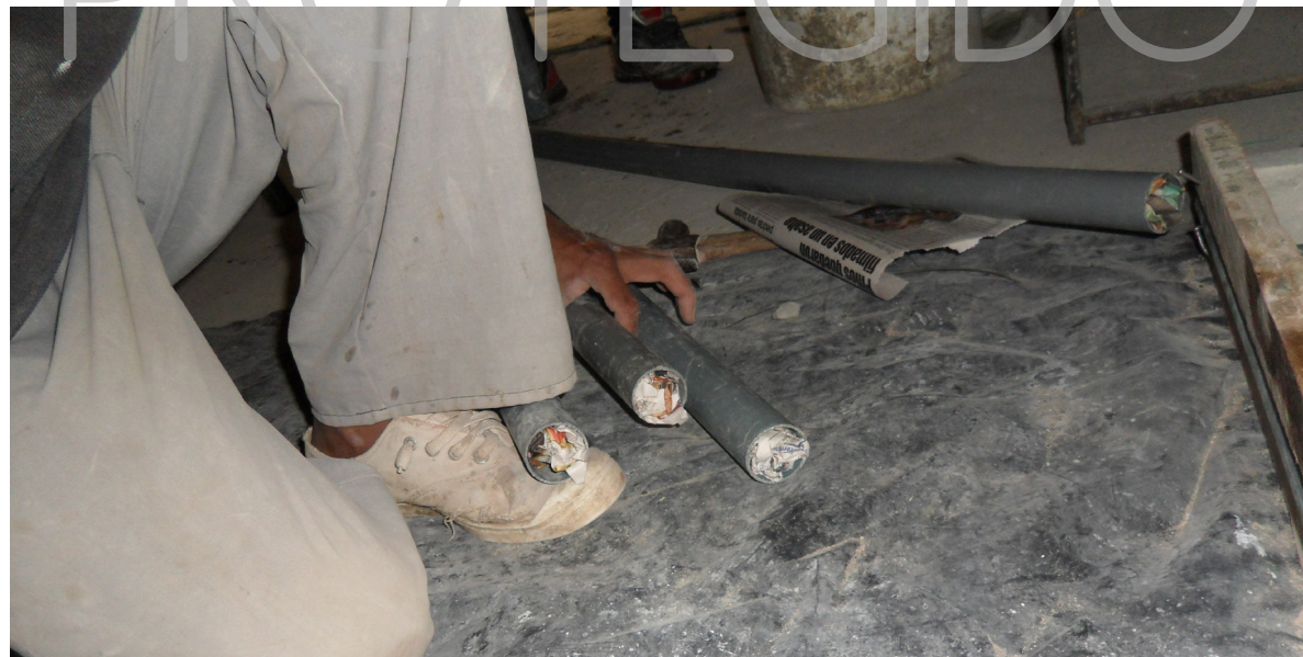
IMAGEN 224: Taponamiento de los tubos con papel periódico Fuente: Realizado por Denisse Aguilera
