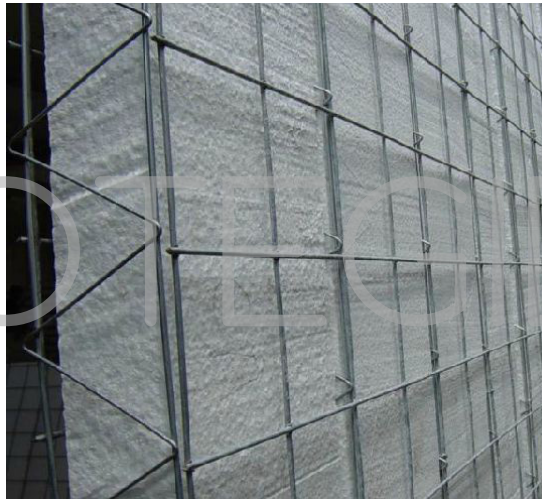
IMAGEN 81: Armado de panel Construpanel Fuente: (AISLAPOL, 2009)
