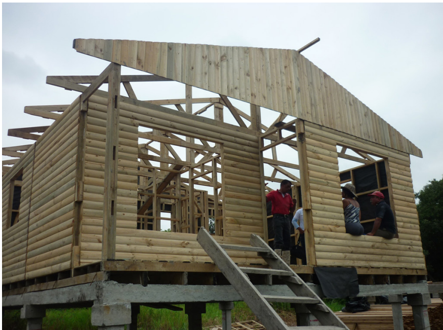
Figura No. 5.5. Proceso de construcción de eco viviendas en Santay
