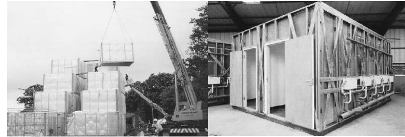
Foto 23. Unidades modulares apiladas en sitio y Modulo de baño con instalaciones. Fuente: (Alacero, 2014).
