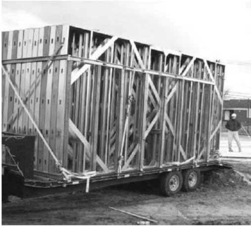
Foto 22. Elementos prefabricados y enviados a obra para el montaje de estructura. Fuente: (Alacero, 2014).
