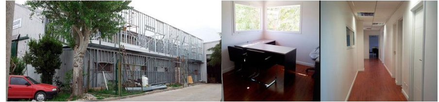
Foto 17. Oficinas Corporativas de Centrosider. Argentina. Fuente: (ARQSTEEL, 2013).
