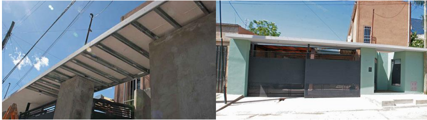
Foto 15. Reforma de marquesina en ingres residencial. Chile. 2014. Fuente: (Soluciones Especiales, 2015).
