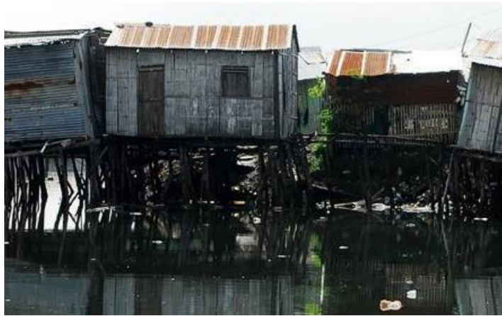
Foto 5. Viviendas sobre el agua carentes de servicios básicos.
