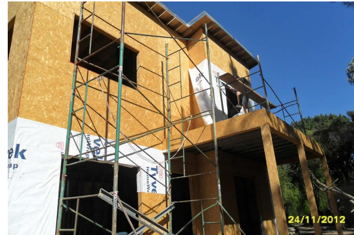
Foto 25. Impermeabilización de placas OSB con membrana de polietileno. Fuente: (STEELframing, 2012).
