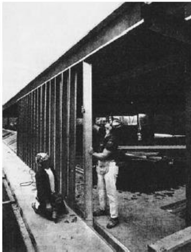
Foto 21. Fabricación y montaje en obra. Fuente: (Alacero, 2014).
