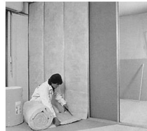
Foto 27. Instalación de lana de vidrio entre montantes de un panel. Fuente: (Alacero, 2014).
