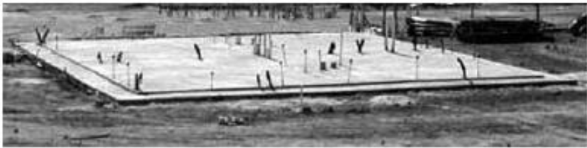
Foto 24. Platea de hormigón y sus instalaciones. Fuente: (Alacero, 2014).
