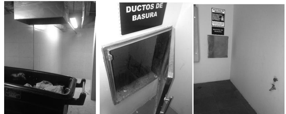
Ilustración 16. Edificio Manglero, ubicado en Samborondón. Fuente: Foto tomada por la autora
