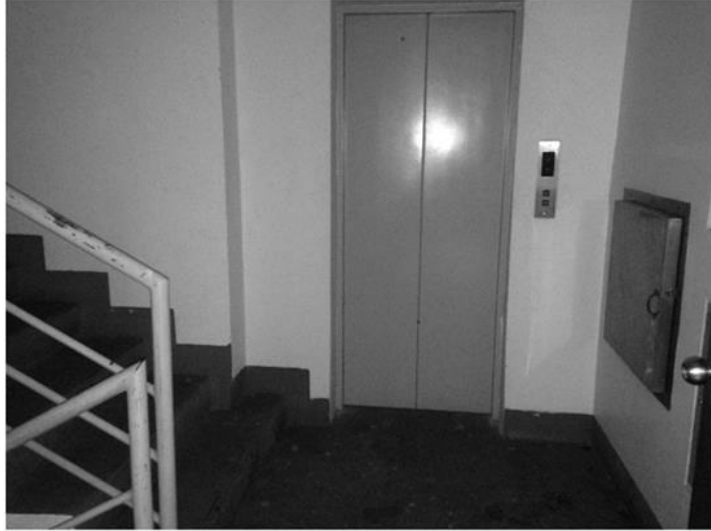
Ilustración 15. Puerta de vertido junto al ascensor. Edificio Scala, ubicado en Samborondón. Fuente: Foto tomada por la autora
