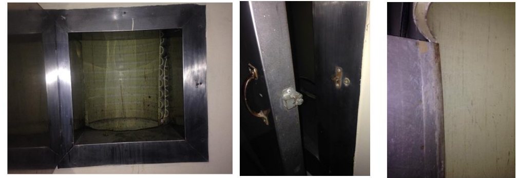
Ilustración 18. Puerta de Vertido. Edificio Scala, ubicado en Samborondón. Fuente: Foto tomada por la autora
