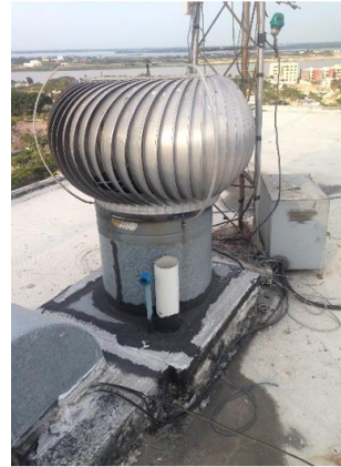
Ilustración 21. Terminación superior del Ducto. Edificio Scala, ubicado en Samborondón. Fuente: Foto tomada por la autora
