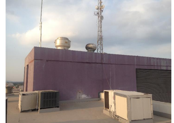
Ilustración 21. Terminación superior del Ducto. Edificio Scala, ubicado en Samborondón. Fuente: Foto tomada por la autora
