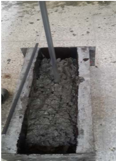
Figure 51 Varillado de vigas
