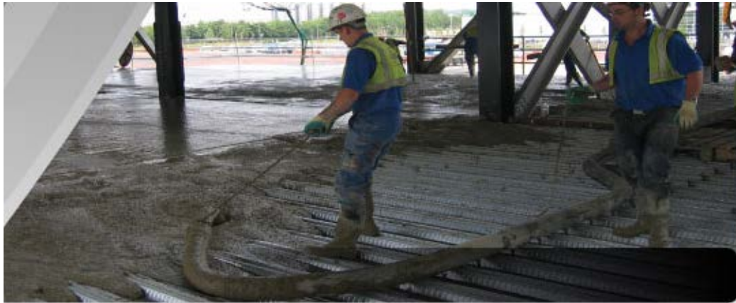
Figure 14 Hormigón con fibra de acero en losas
