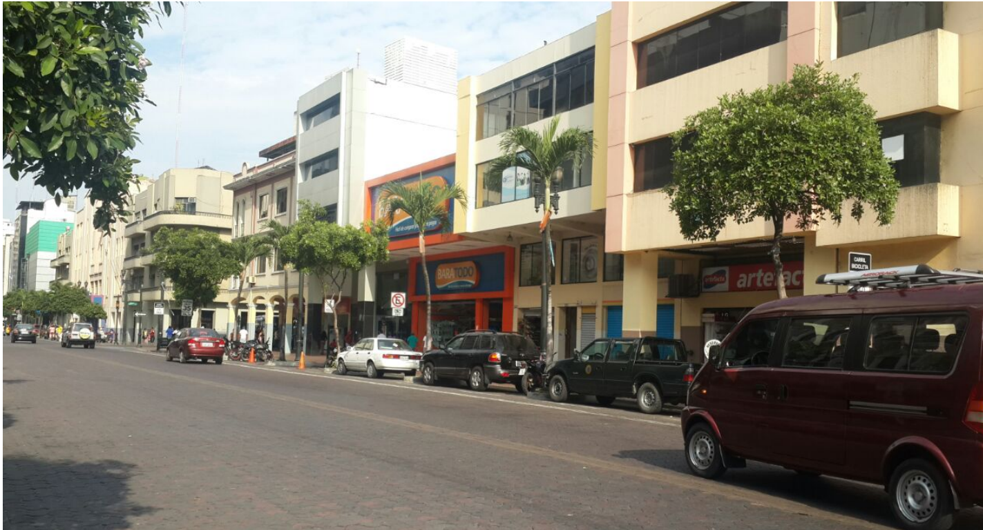
Imagen # 12 Estado técnico de la vía
