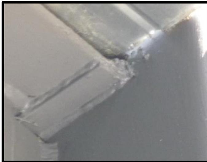
**Foto # 43: Soldadura en platina de respaldo en patín superior de viga.**
