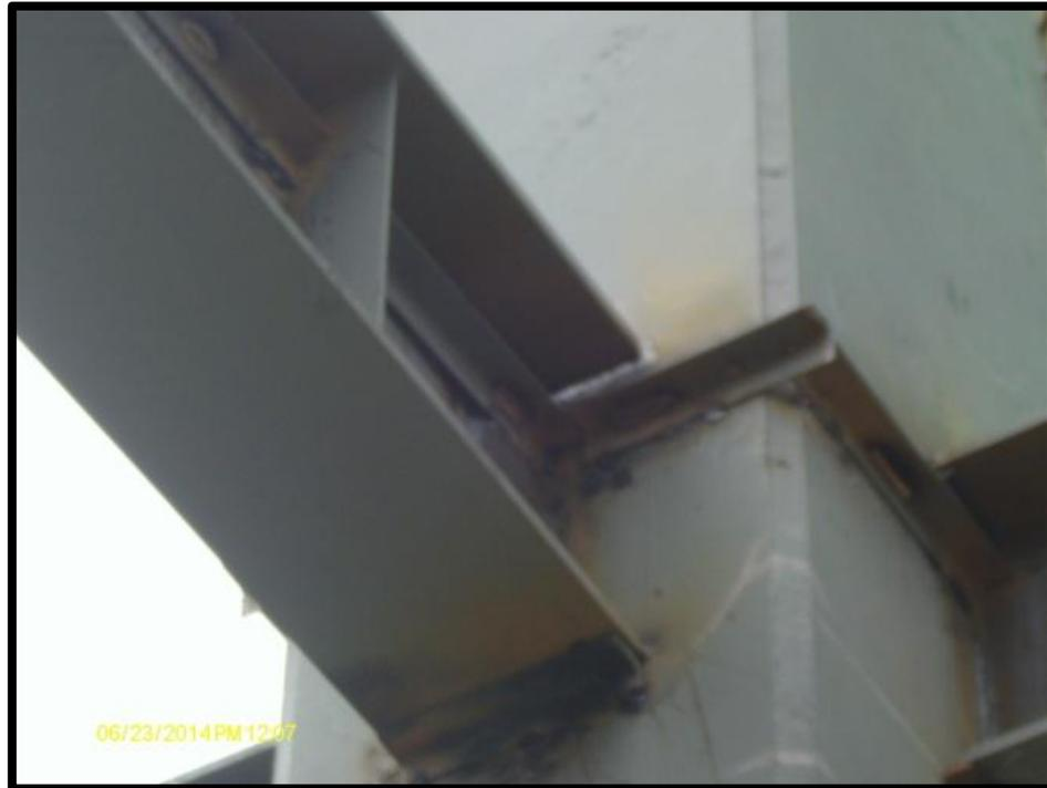
Foto # 44: Soldadura patín superior e inferior de unión viga-columna
