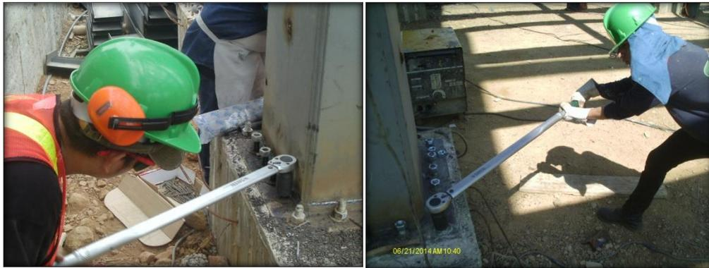
**Foto # 41: Utilización de torquímetro**
