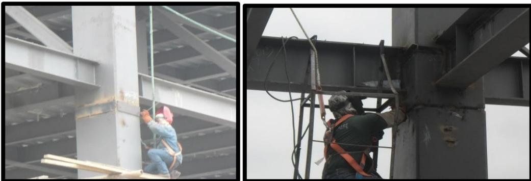
**Foto # 33 Soldada de refuerzos en uniones de tramos de columnas**
