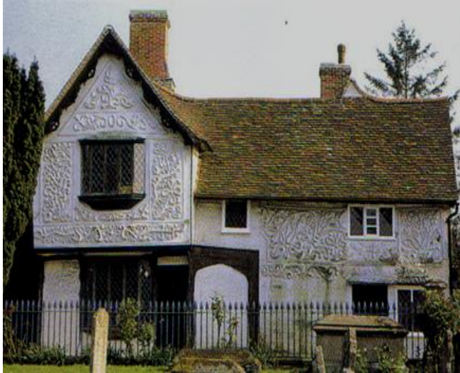
Figura 21.- Detalle del revoco de cal en la fachada de la casa de la figura anterior
