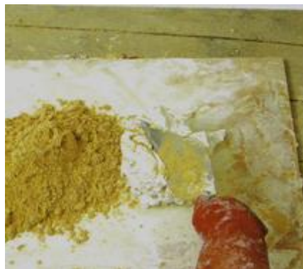
Figura 16.- Preparación de Revoco de Cal
