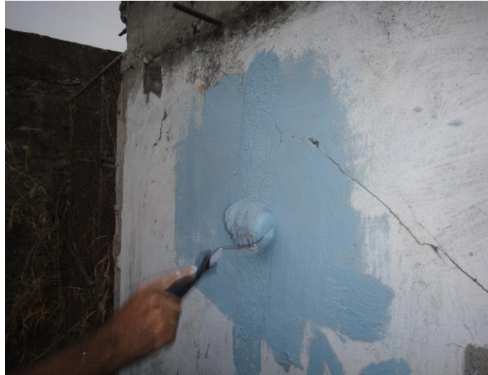
Figura 33.- Aplicación de la Pintura a Base de Hidróxido de Calcio
