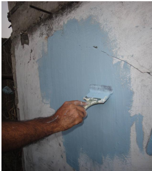
Figura 34.- Aplicación de la Pintura a Base de Hidróxido de Calcio
