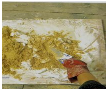
Figura 17.- Preparación de Revoco de Cal
