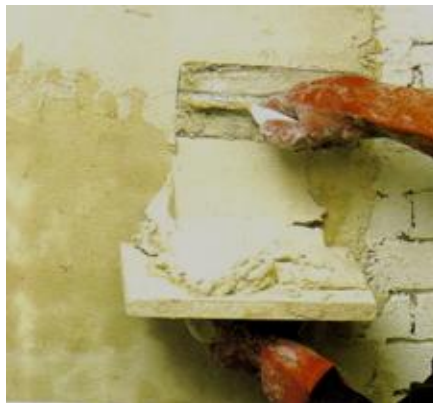
Figura 19.- Preparación de Revoco de Cal Fuente: Secretos Decorativos: Acabados
