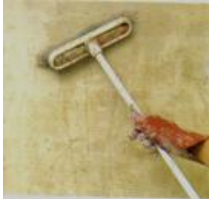
Figura 18.- Preparación de Revoco de Cal Fuente: Secretos Decorativos: Acabados
